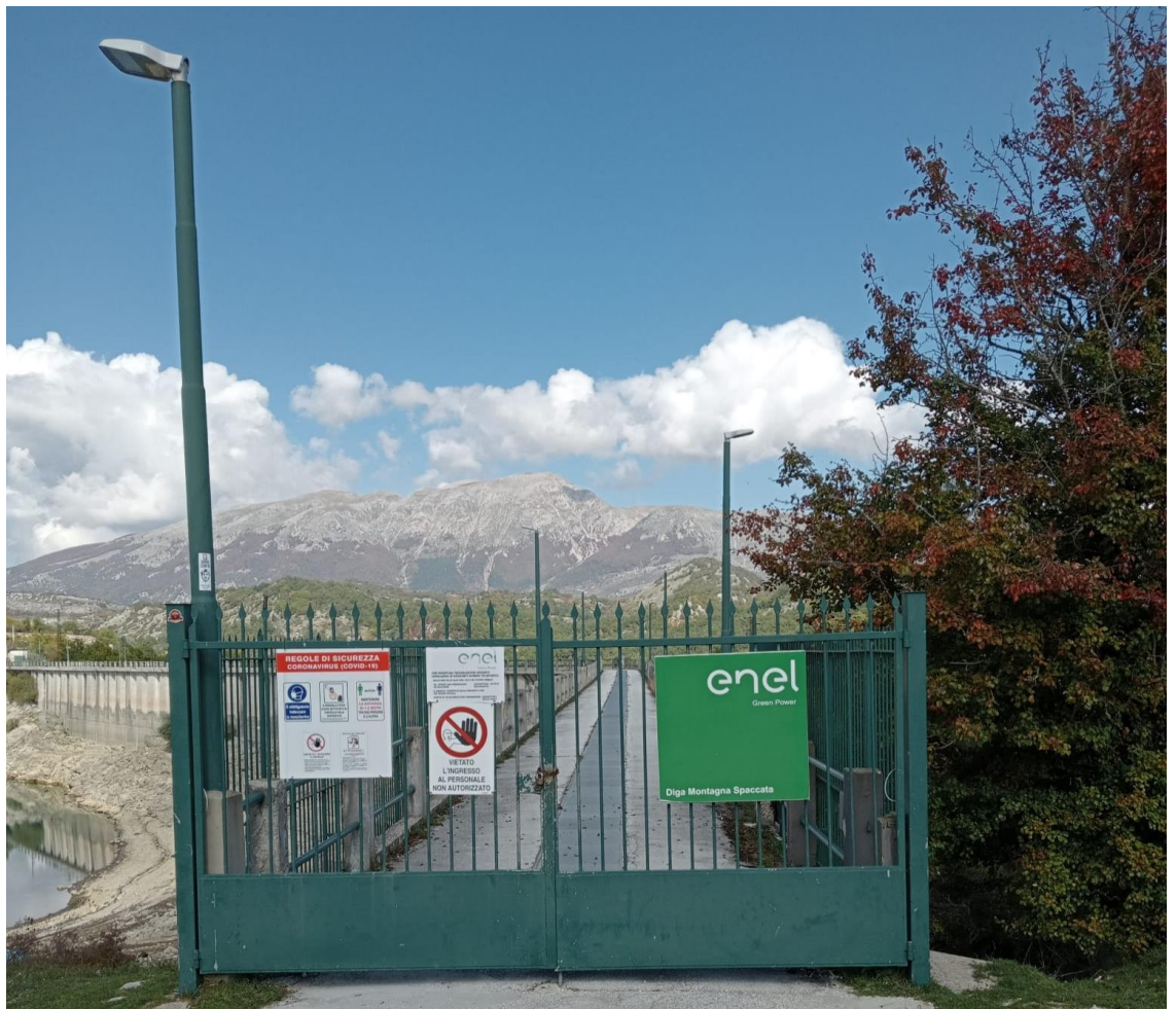
VISTA 05: Accesso Enel alla diga del bacino di Montagna Spaccata
