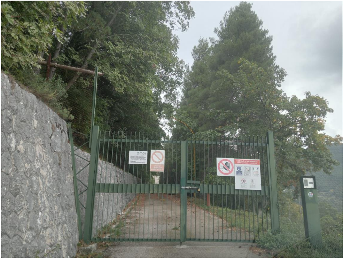
VISTA 11: Area di cantiere n.5
