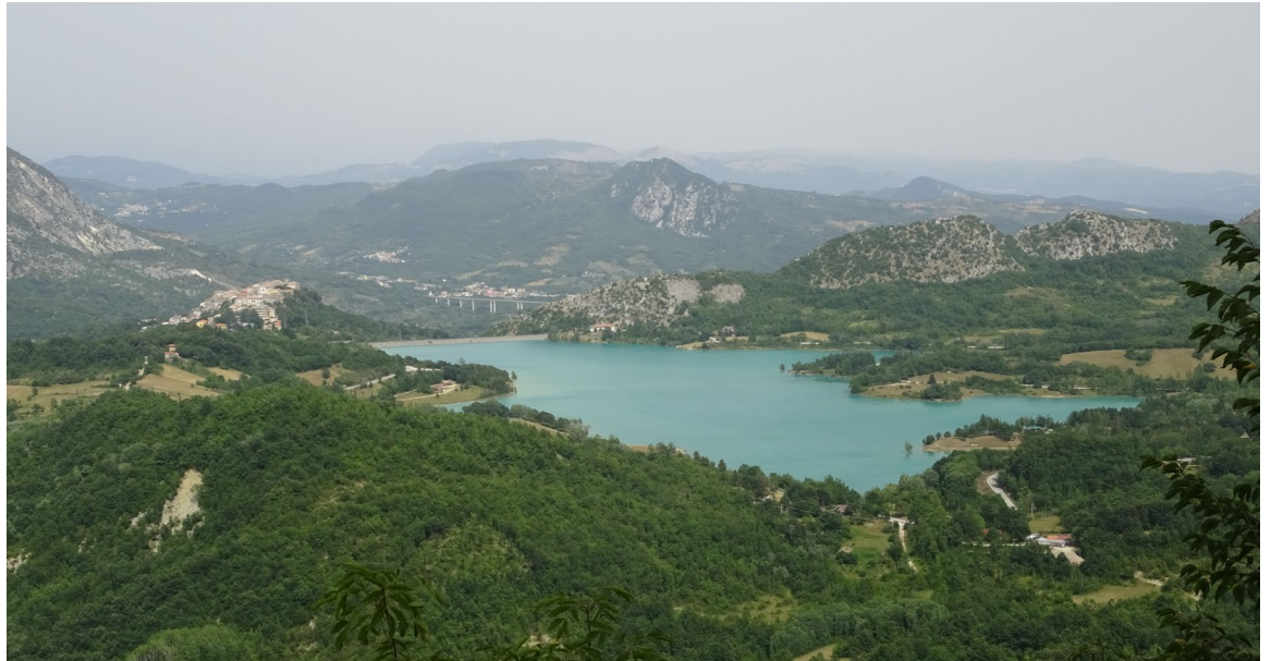
Figura 2-3: Serbatoio di Castel San Vincenzo
