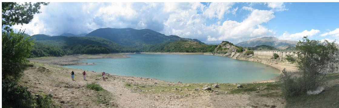
Figura 2-2: Serbatoio di Montagna Spaccata
