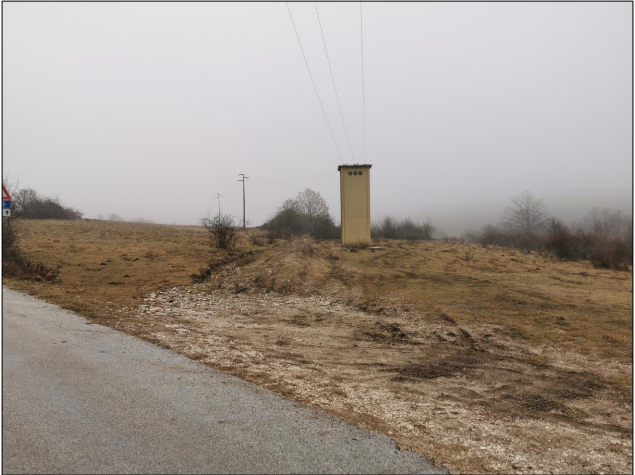
Figura 20 - Punto P15. Inquadramento dell'area interessata dalla collocazione futura della viabilità d'accesso alla stazione elettrica
