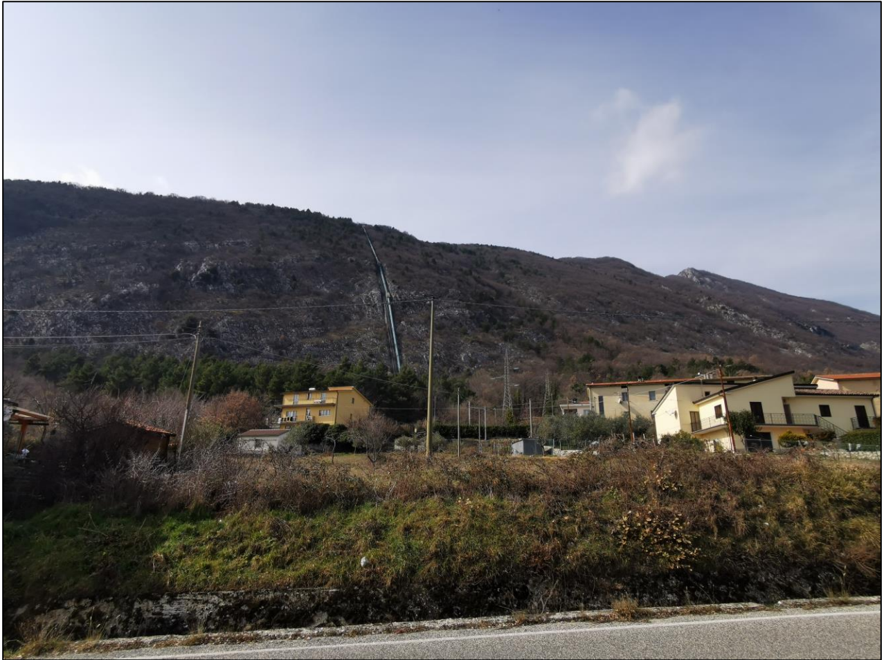
Figura 7 - Punto P2. Inquadramento dell'area interessata dalla collocazione futura del portale SE e dell'elettrodotto
