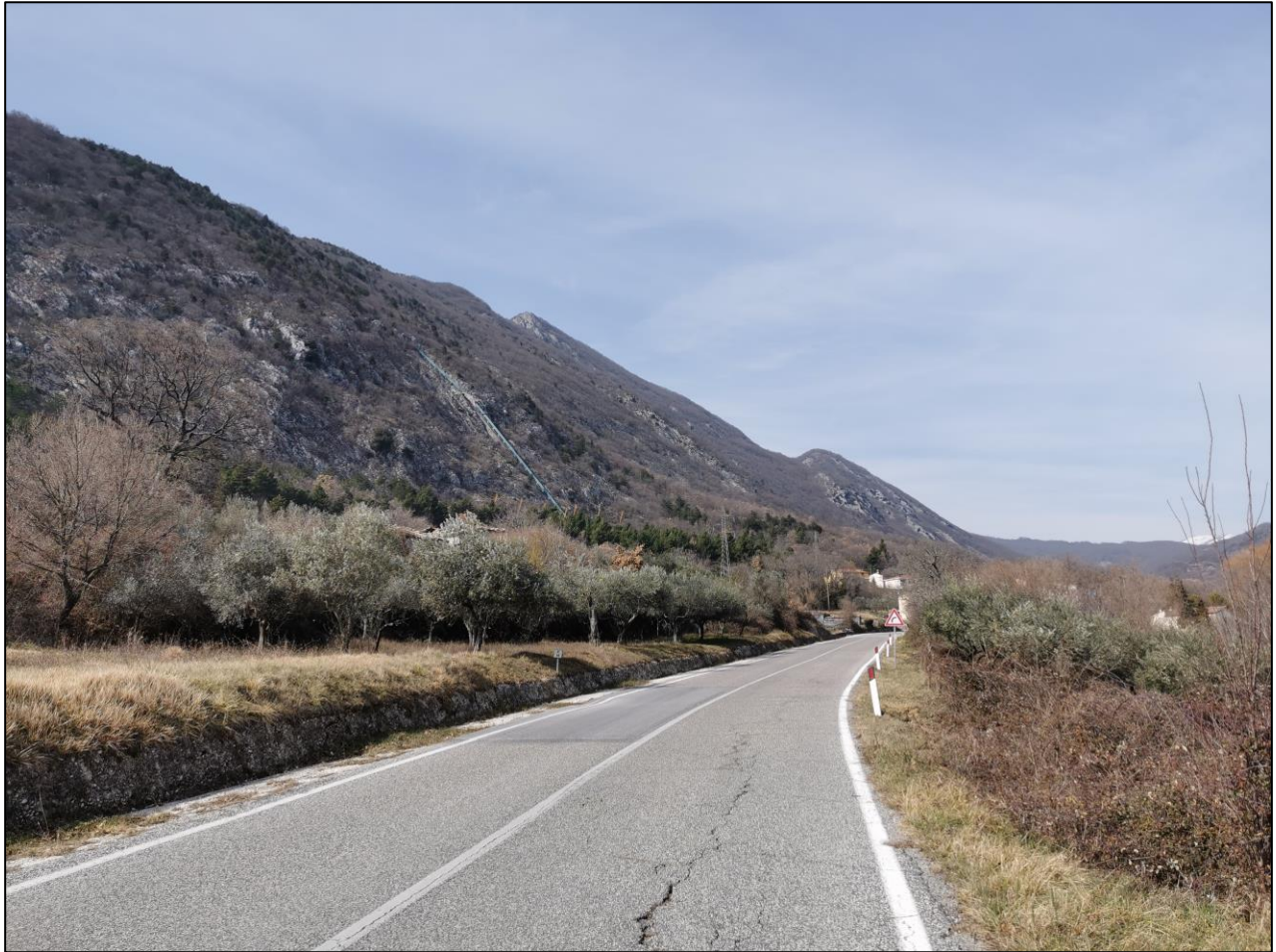
Figura 6 - Punto P1. Inquadramento dell'area interessata dalla collocazione futura del portale SE, dell'elettrodotto e del sostegno S2
