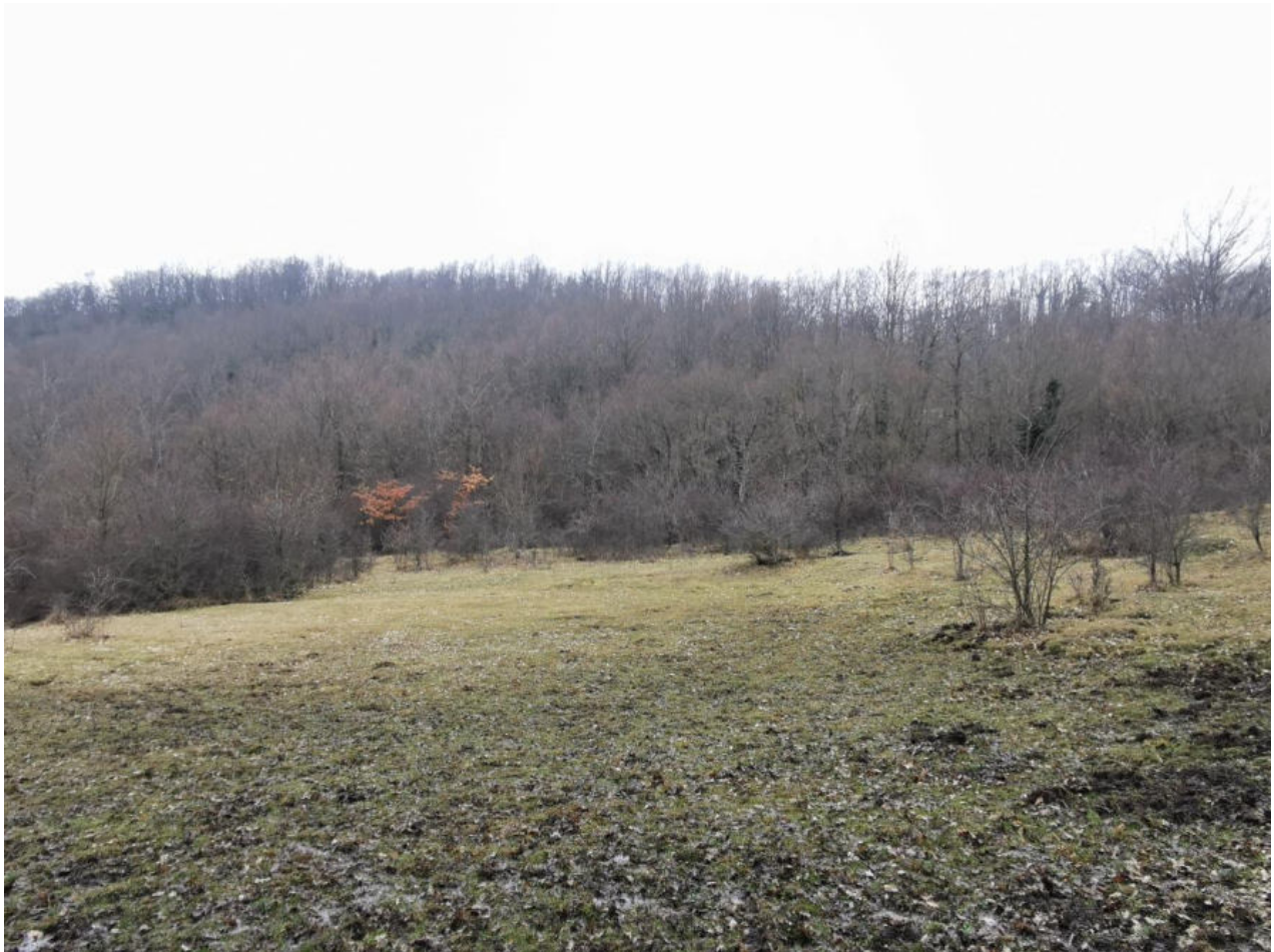
Figura 33 – PV20 Foto della localizzazione dell'elettrodotto e della posizione del traliccio S8 su pascolo
