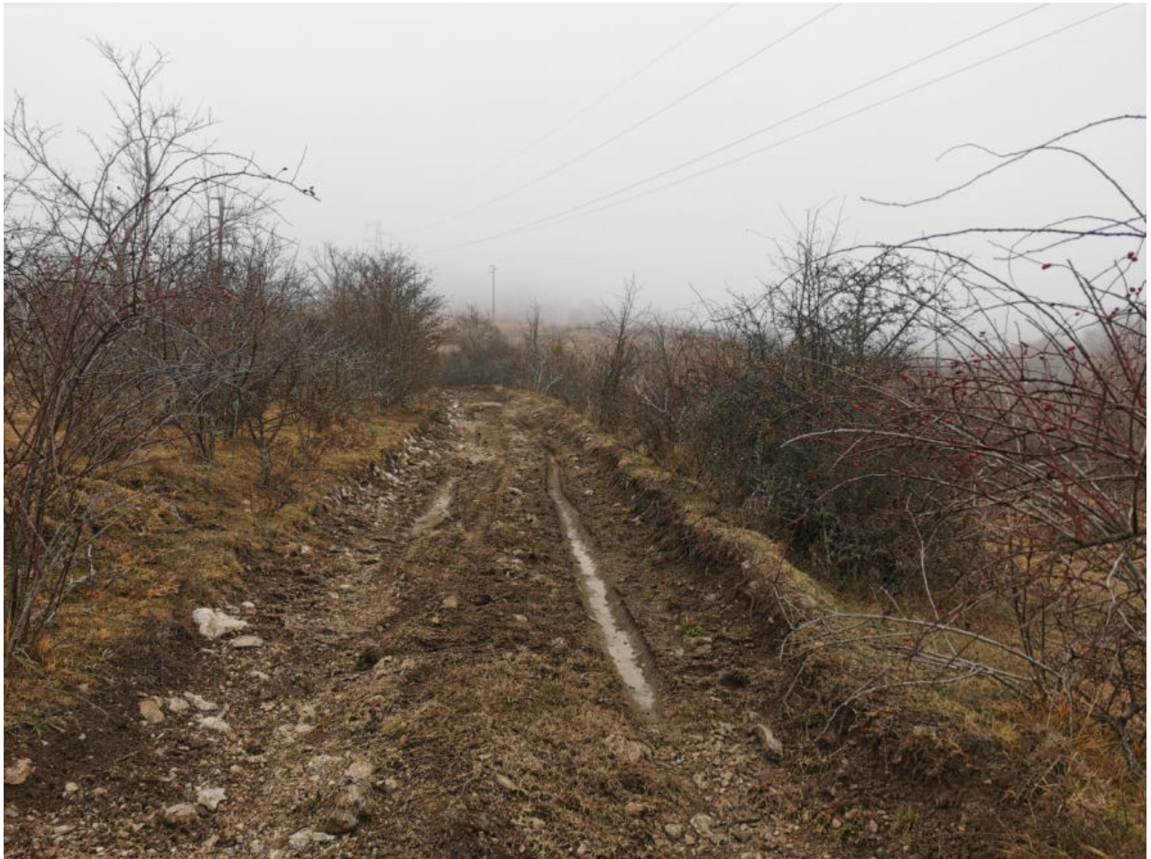
Figura 19 – PV6 Foto della viabilità su strada bianca esistente di accesso alla futura SE
