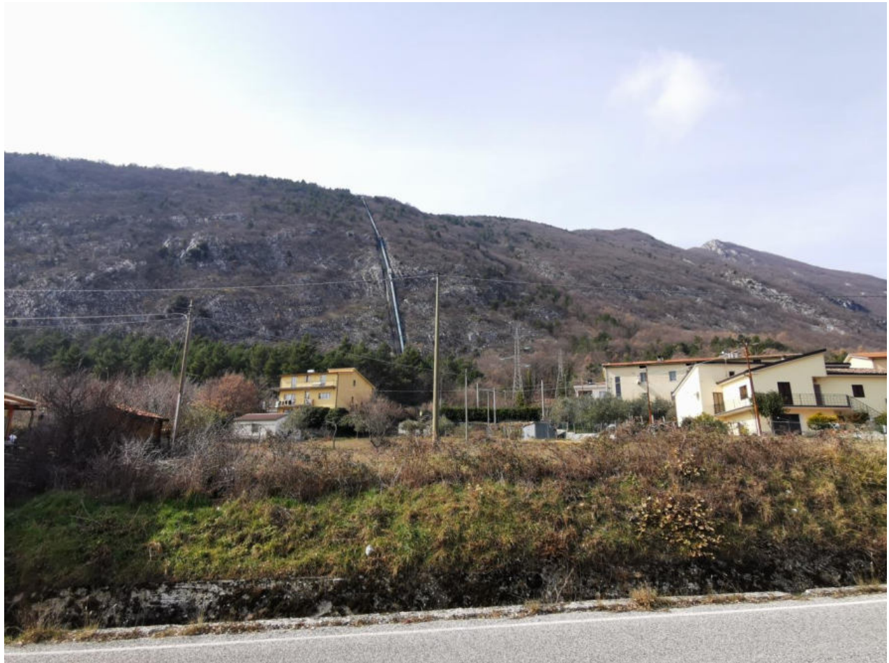
Figura 51 – PV38 Foto della localizzazione dell'elettrodotto in arrivo alla SSE a servizio della centrale idroelettrica
