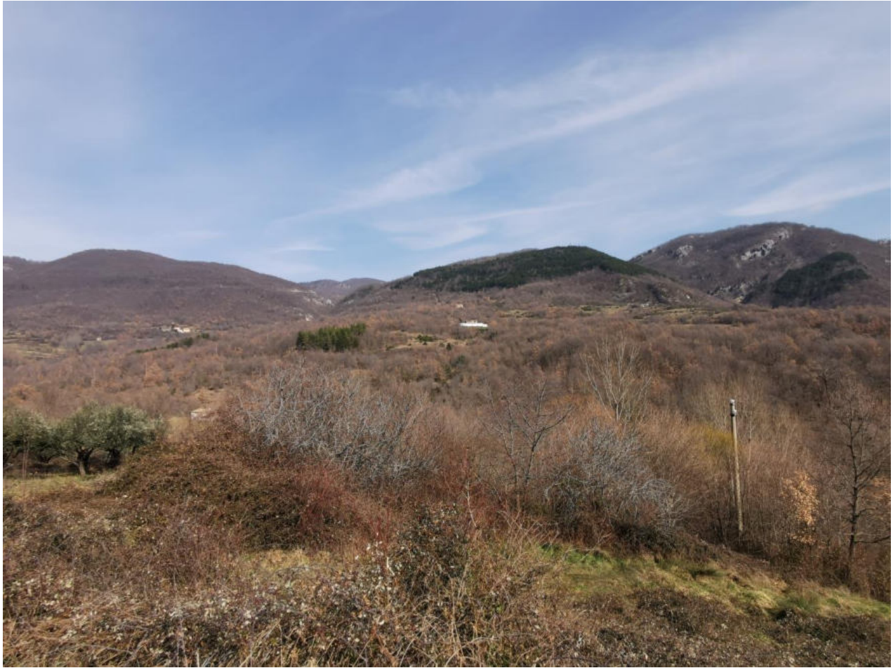
Figura 52 – PV39 Foto panoramica inquadrante il tratto di elettrodotto con i tralicci S3, S4, S5 e S6
