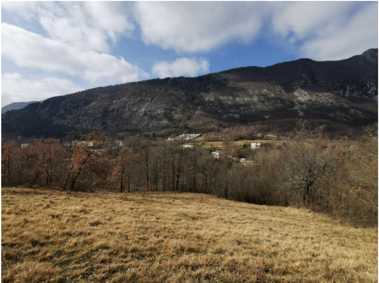
Figura 44 – PV31 Foto della localizzazione dell'elettrodotto e della posizione del traliccio S3 su pascolo
