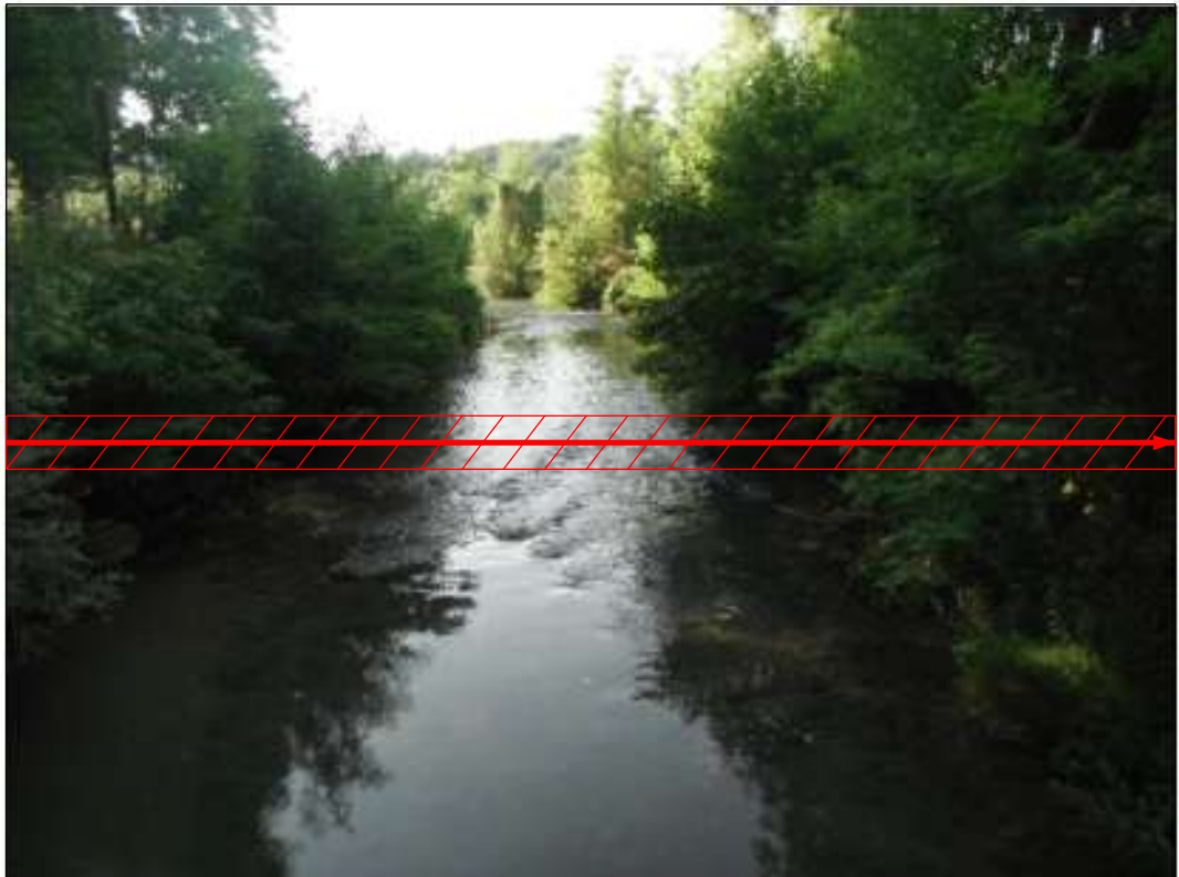
Attraversamento Direct Pipe Fiume Elsa 4°
