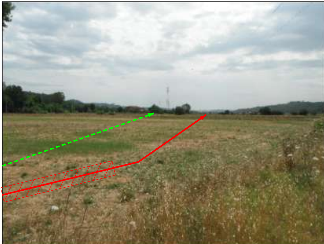
Punto di uscita TOC Fiume Elsa 1° e parallelismo in area agricola
