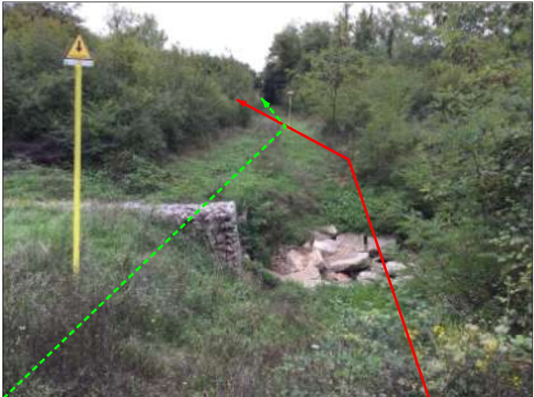
Attraversamento torrente Tressa KP 36+940
