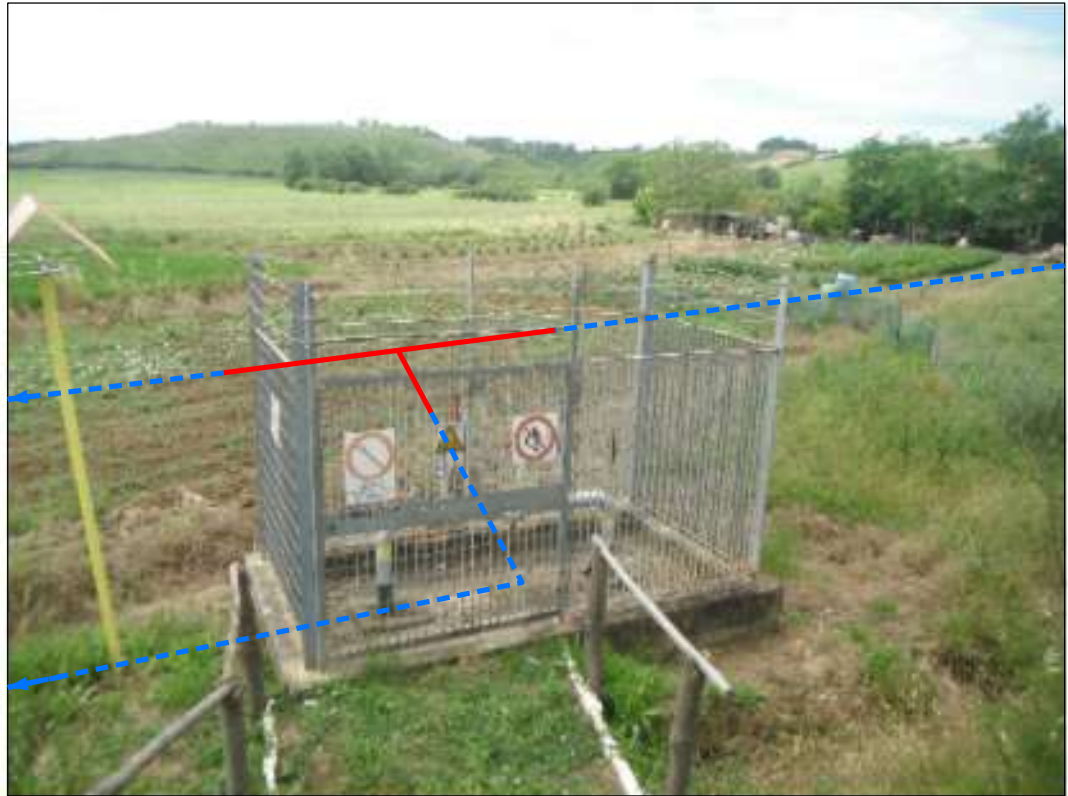
Rifacimento stacco a Tee a monte impianto esistente
