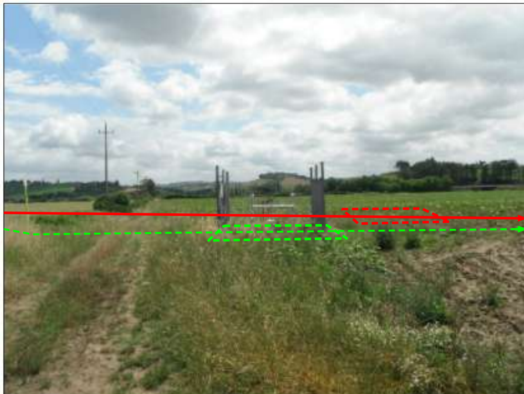
Impianto PIL in progetto (loc. P. Filistrucchio) e impianto in rimozione
