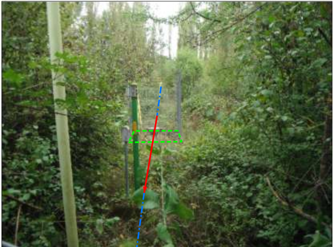
Segnapig esistente da rimuovere
