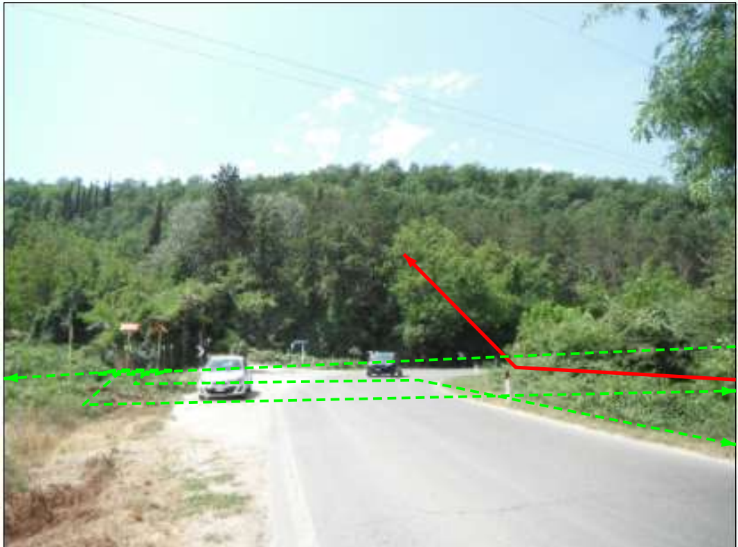
Attraversamento S.P. n.95 e impianto in rimozione
