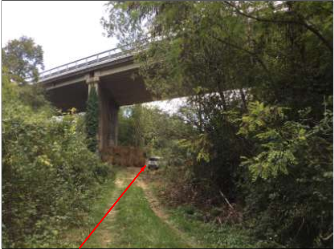
Passaggio sotto Raccordo Autostradale n.3
