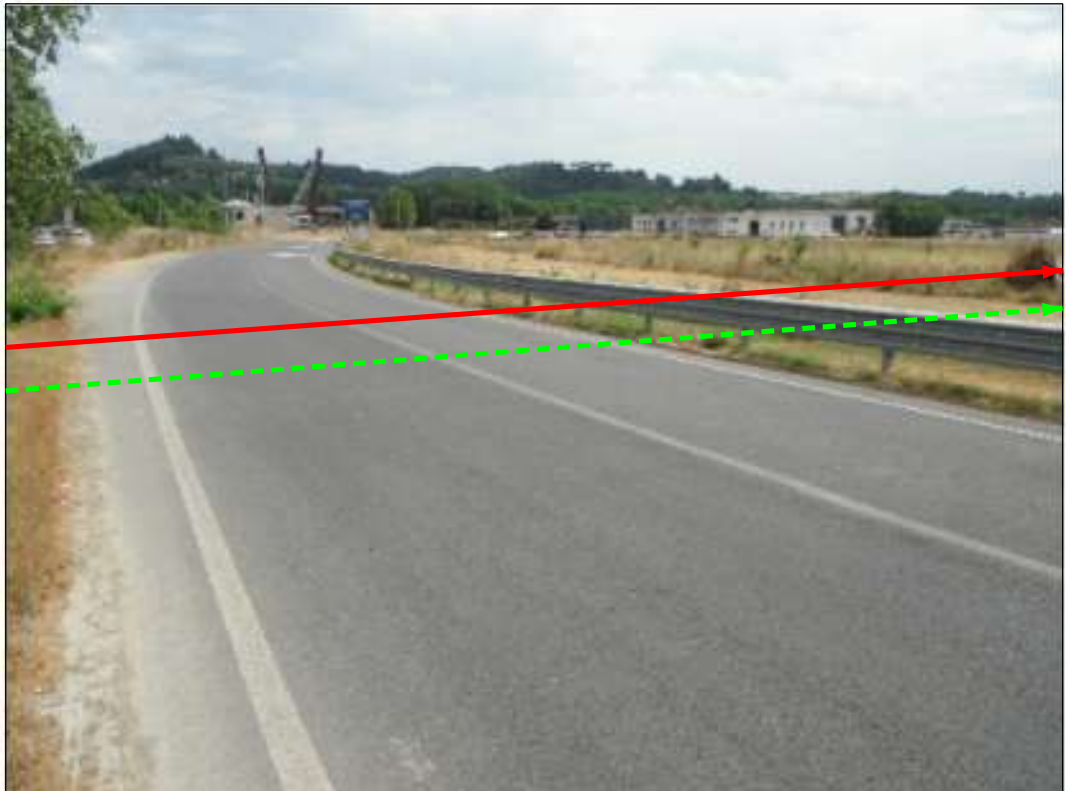
Attraversamento S.R. n. 429
