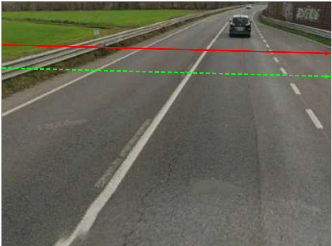
Attraversamento S.R. n. 429
