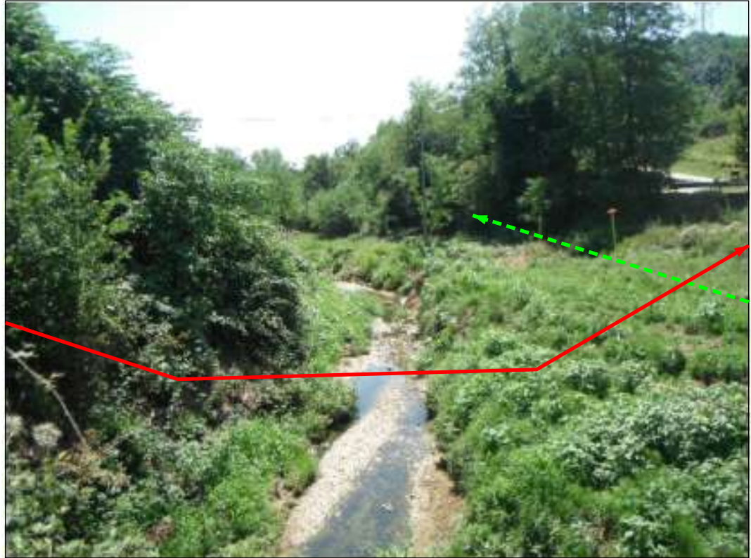
Attraversamento torrente Tressa KP 38+690
