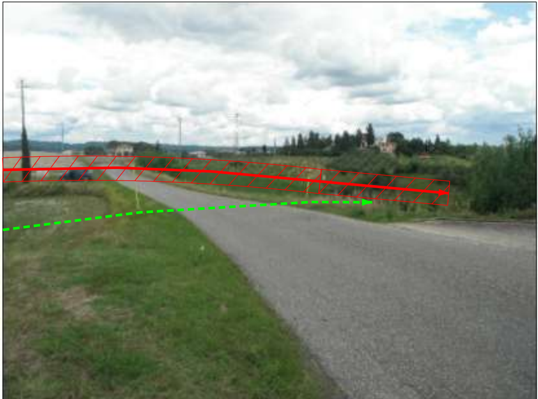
Attraversamento SP n.50 con TOC di S. Donnino
