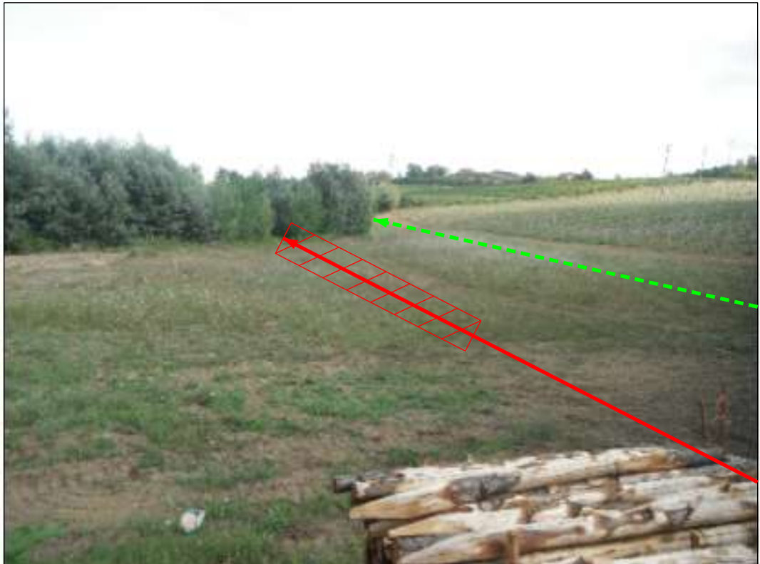
Punto di uscita MT T. Tressa 9° 10° 11°
