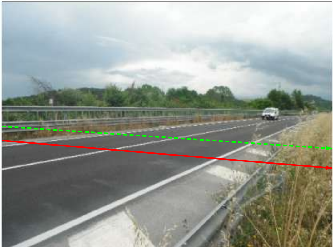
Attraversamento S.R. n.429
