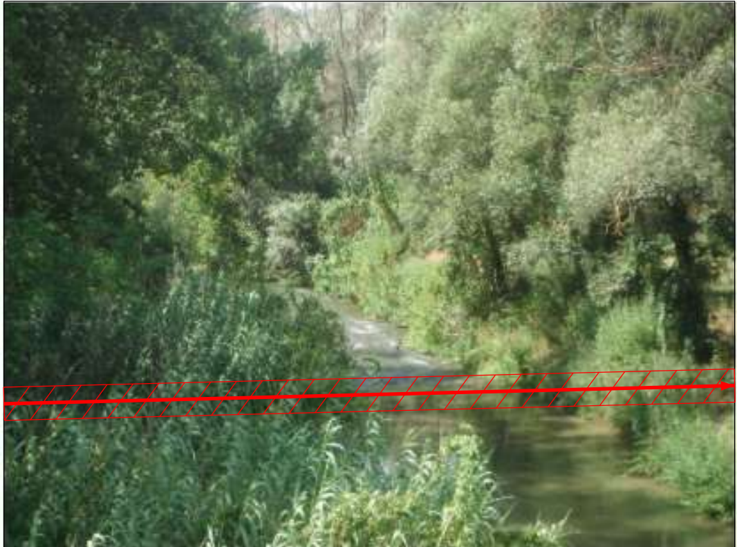
Attraversamento TOC Fiume Elsa 2° e 3°
