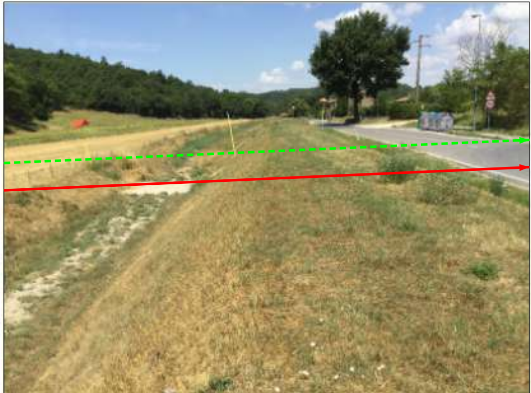
Attraversamento fosso Ruota (rif. All. Com. Monteriggioni 1° presa)
