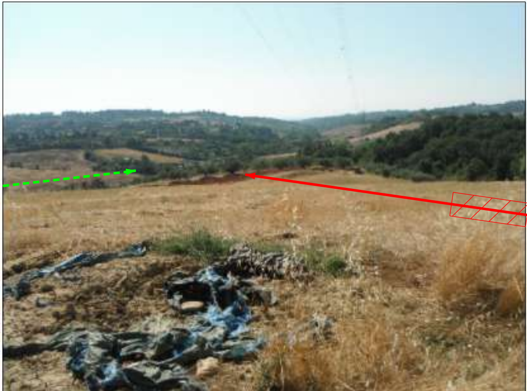
Punto di ingresso TOC Loc. Fulino
