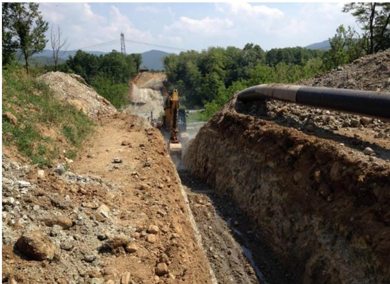
**Fig. 1.4 – Scavo per l'alloggiamento della condotta.**
