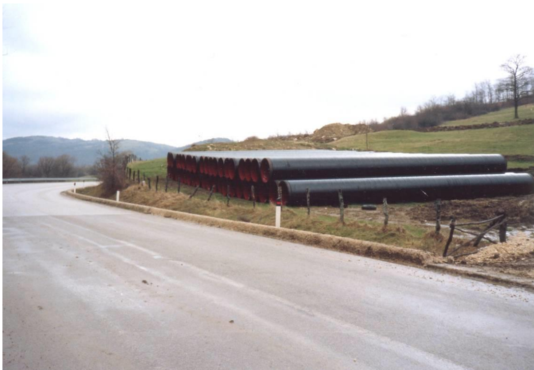
Fig. 7-1: Piazzole di accatastamento tubazioni.
