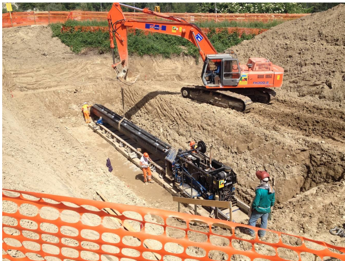
Fig. 7-16: trivella spingitubo
