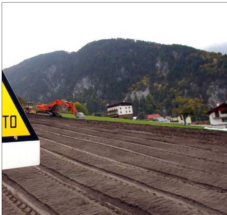
Fig. 7-12: redistribuzione dello strato humico superficiale
