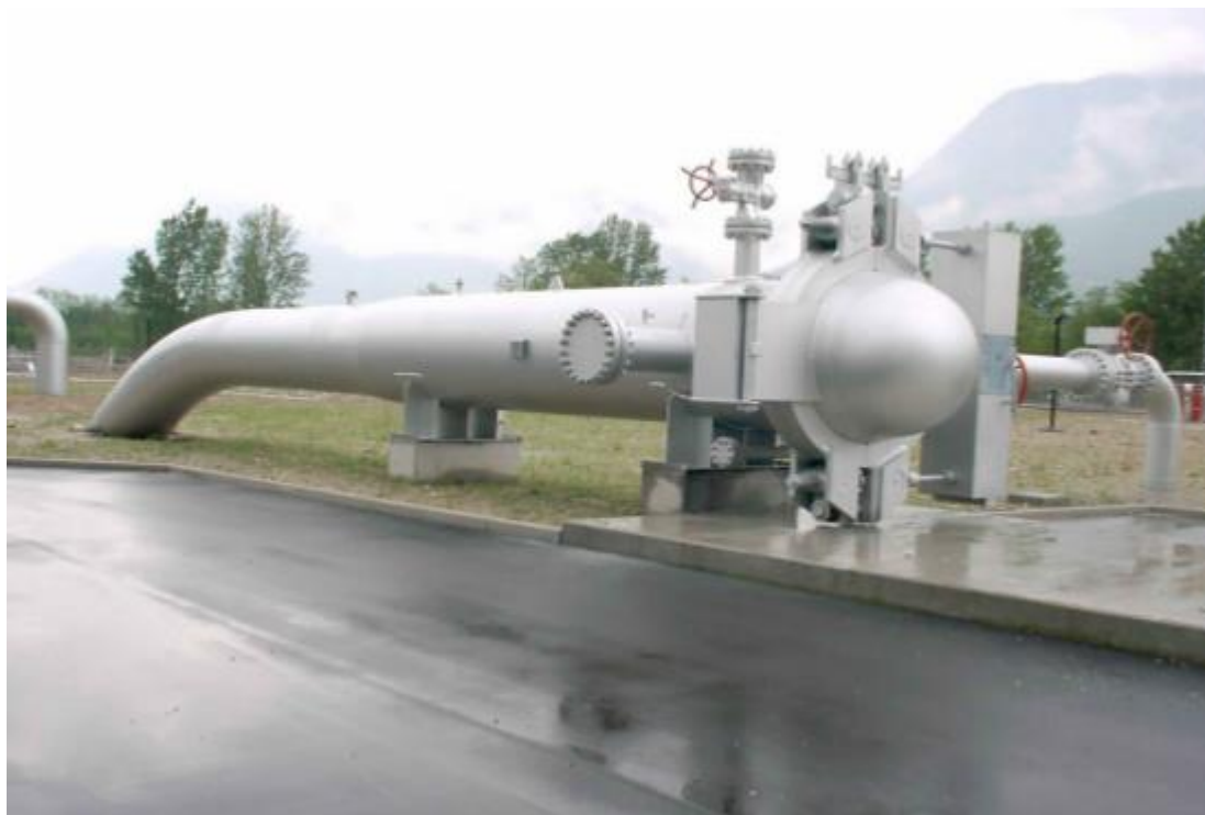
Fig. 7-28: Punto di lancio e ricevimento pig
