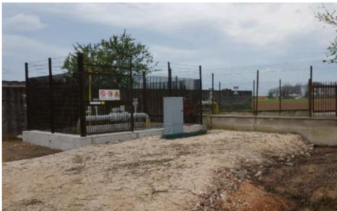
Fig. 7-27: Esempio di impianto al termine dei lavori.
