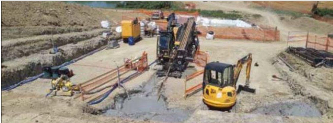
Fig. 7-18: Rig e area di cantiere
