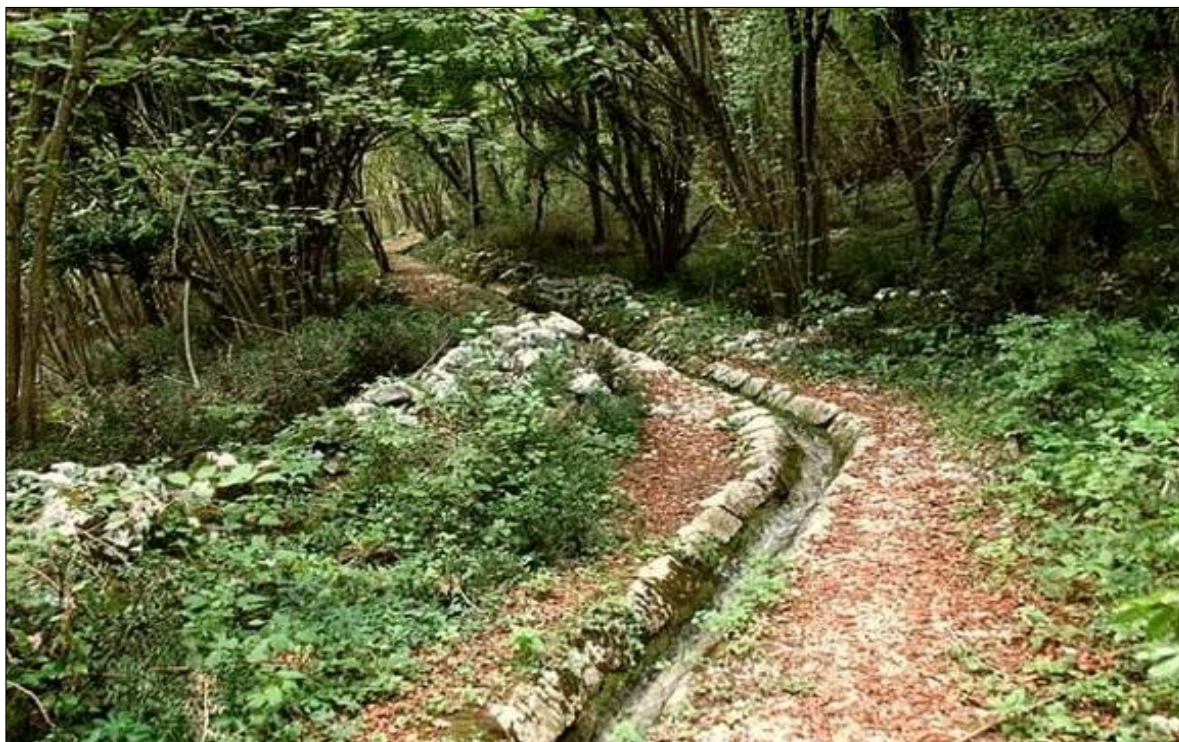
Fig. 8-17 - canaletta in terra e/o pietrame
