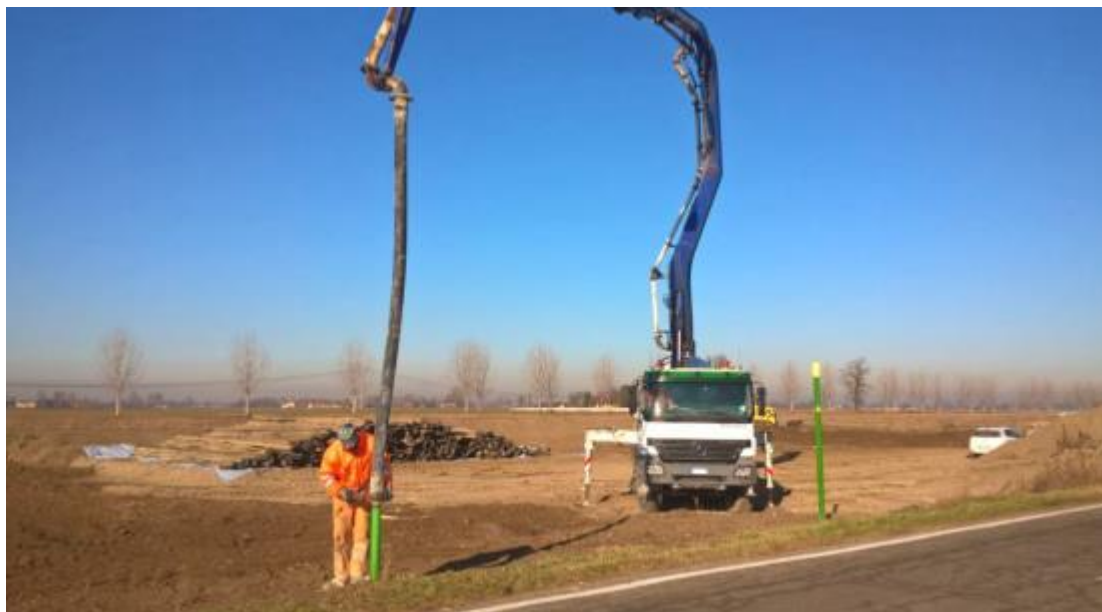
Fig. 7-37: Inertizzazione del tubo di protezione
