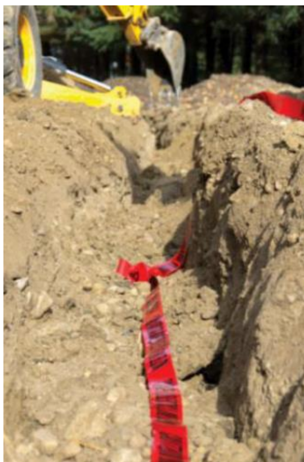
Fig. 7-34: Scavo della trincea e rimozione nastro di avvertimento
