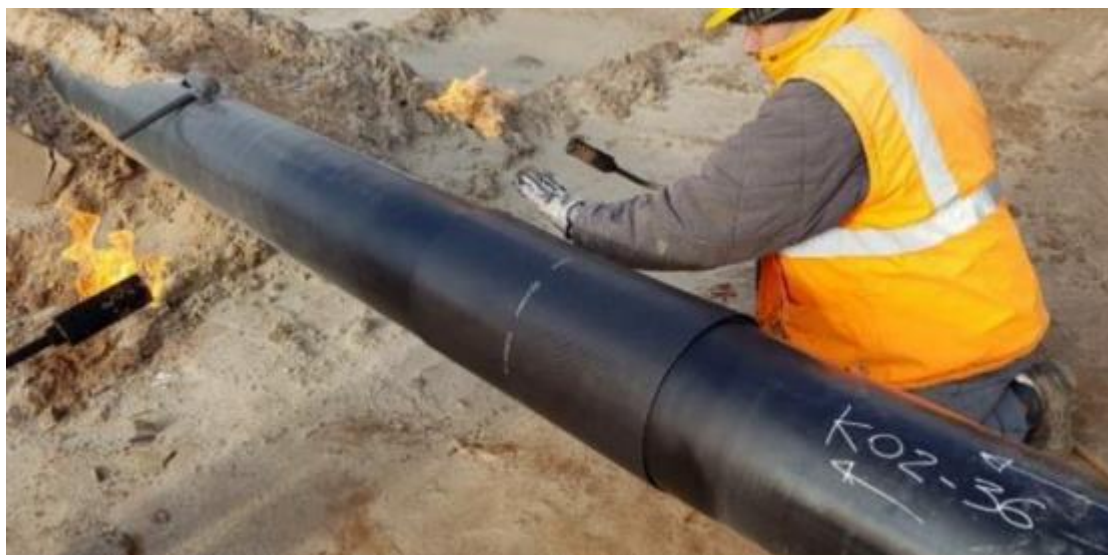
Fig. 7-9: applicazione manuale di una fascia termorestringente sul giunto di saldatura
