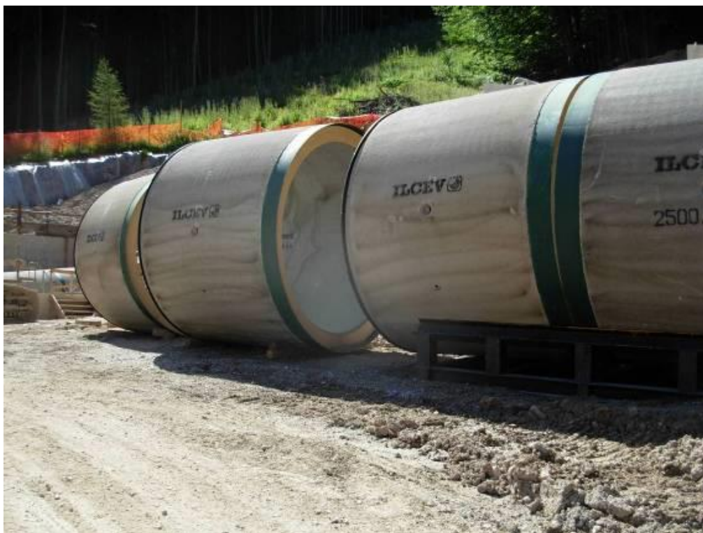
Fig. 7-24: stoccaggio tubi in c.a.
