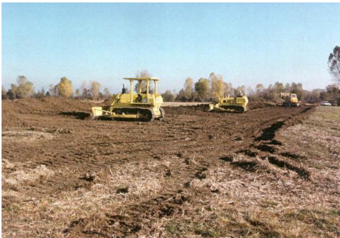
Fig. 7-2: Apertura dell'area di passaggio
