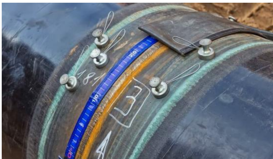
Fig. 7-7: controlli non distruttivi sulla saldatura
