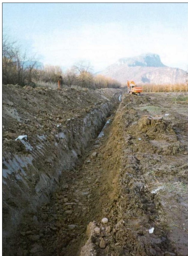
Fig. 7-11: operazioni di rinterro della condotta
