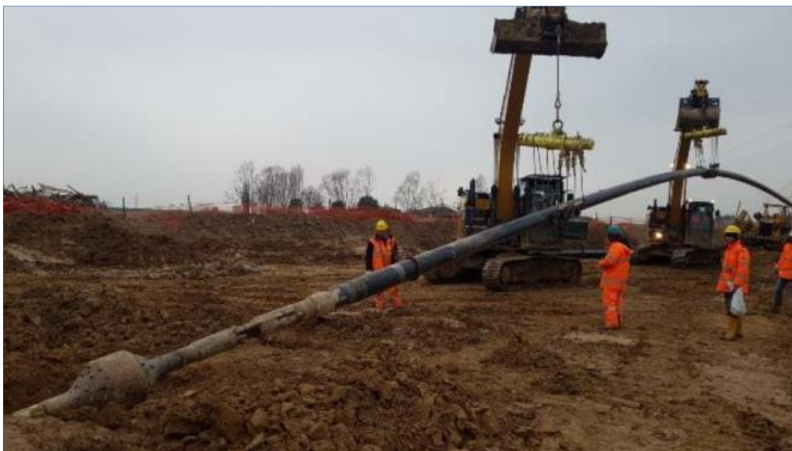
Fig. 7-19: Operazione di varo della TOC
