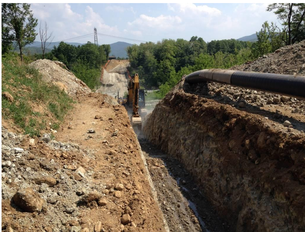
Fig. 7-8: scavo della trincea
