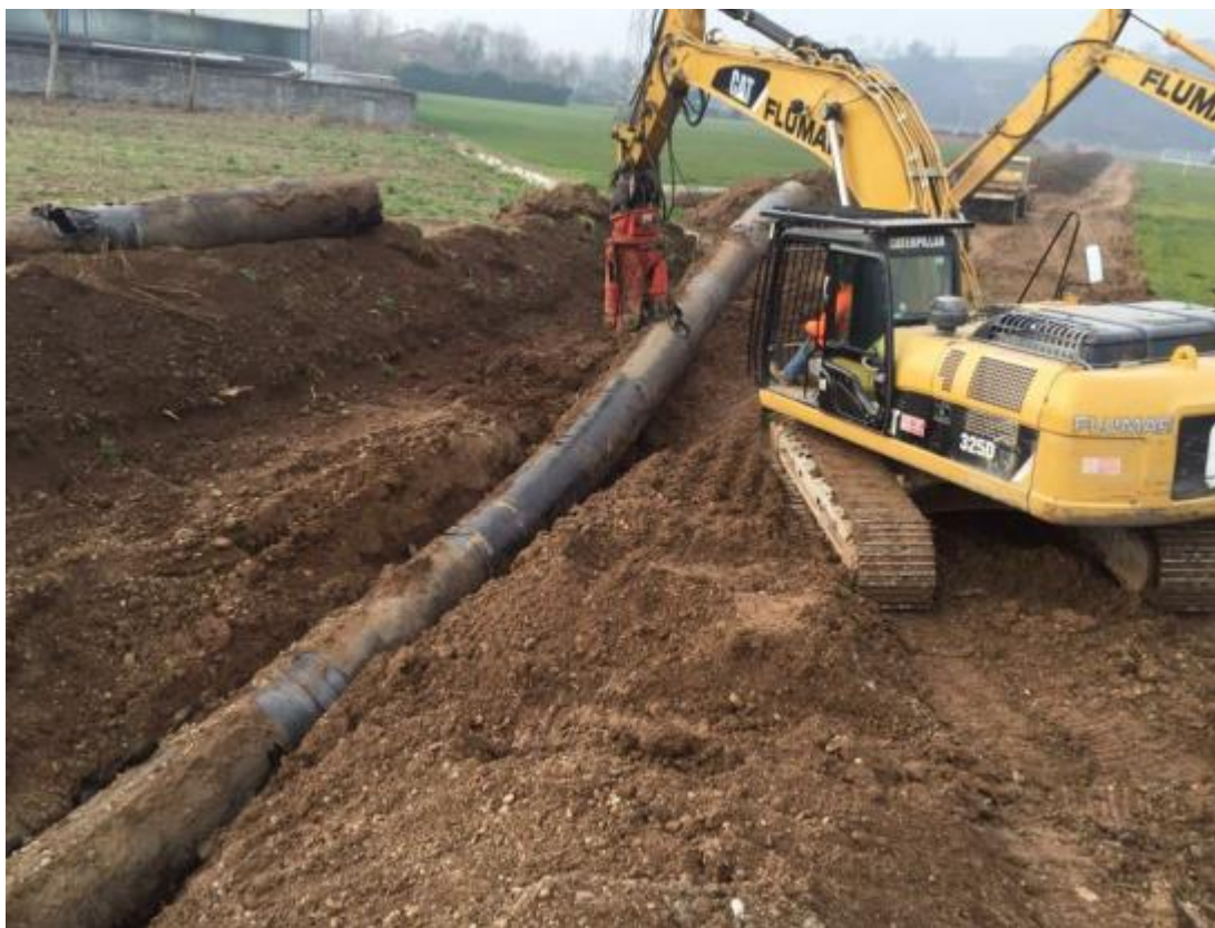
Fig. 7-36: Sollevamento tubazione sezionata da rimozione
