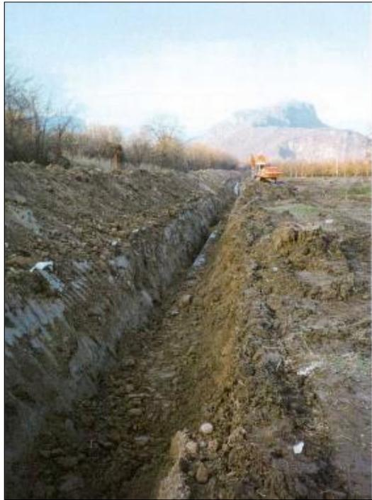
**Fig. 4.10 - Operazione di rinterro della condotta.**
