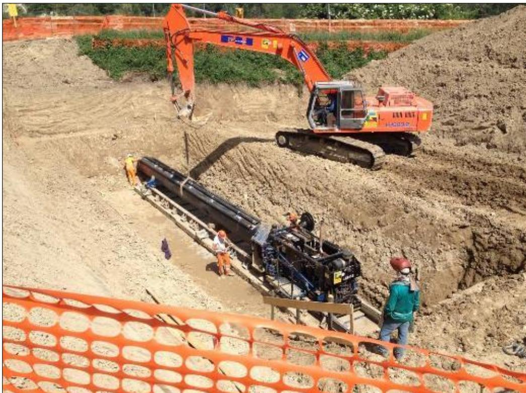
**Fig. 4.15 - trivella spingitubo.**
