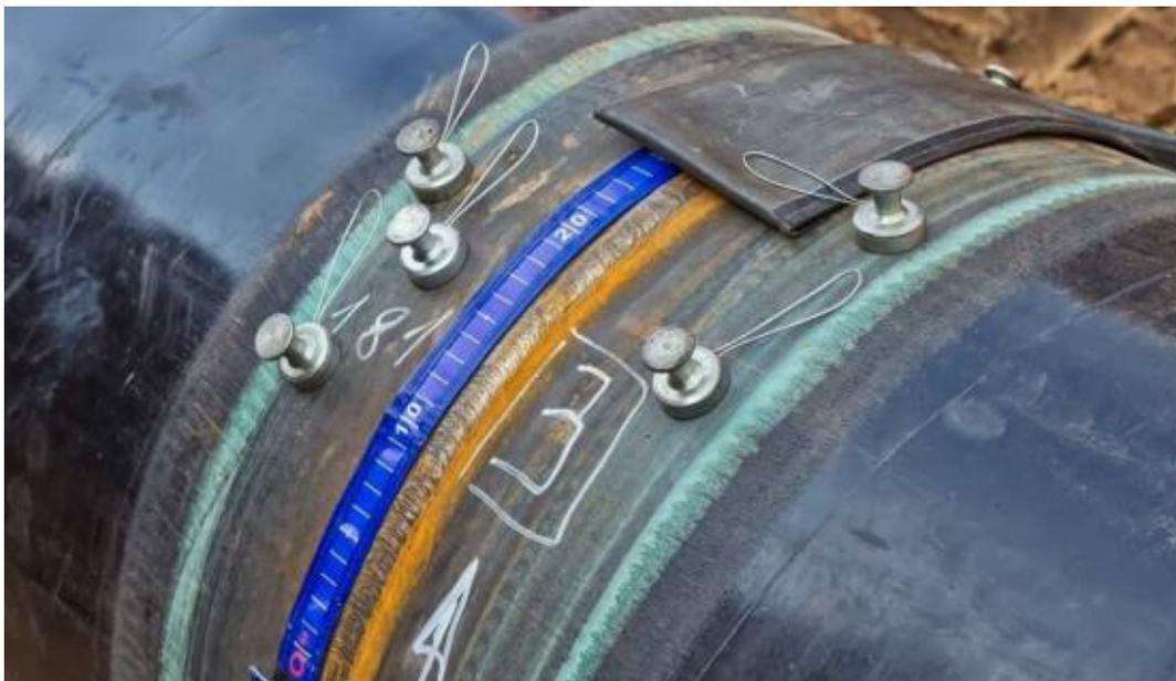
**Fig. 4.7 - Controlli non distruttivi sulla saldatura.**
