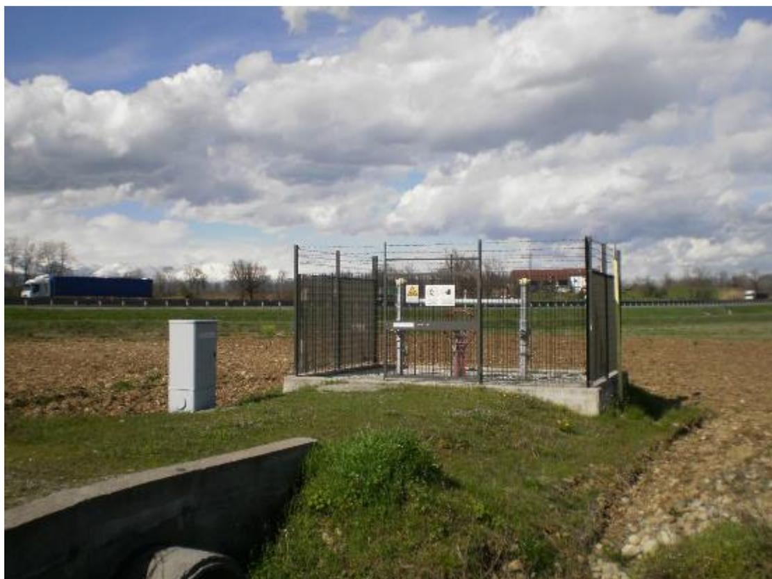
**Fig. 4.25 - Esempio di impianto di intercettazione di linea PIL.**
