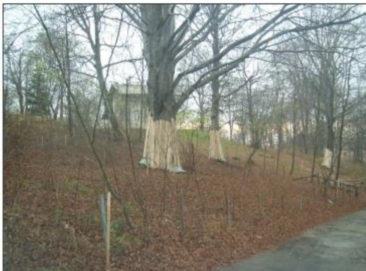
**Figura 8.1 – Tecnica di salvaguardia di alberi posti all'interno dell'area di passaggio prima dell'inizio dei lavori.**
