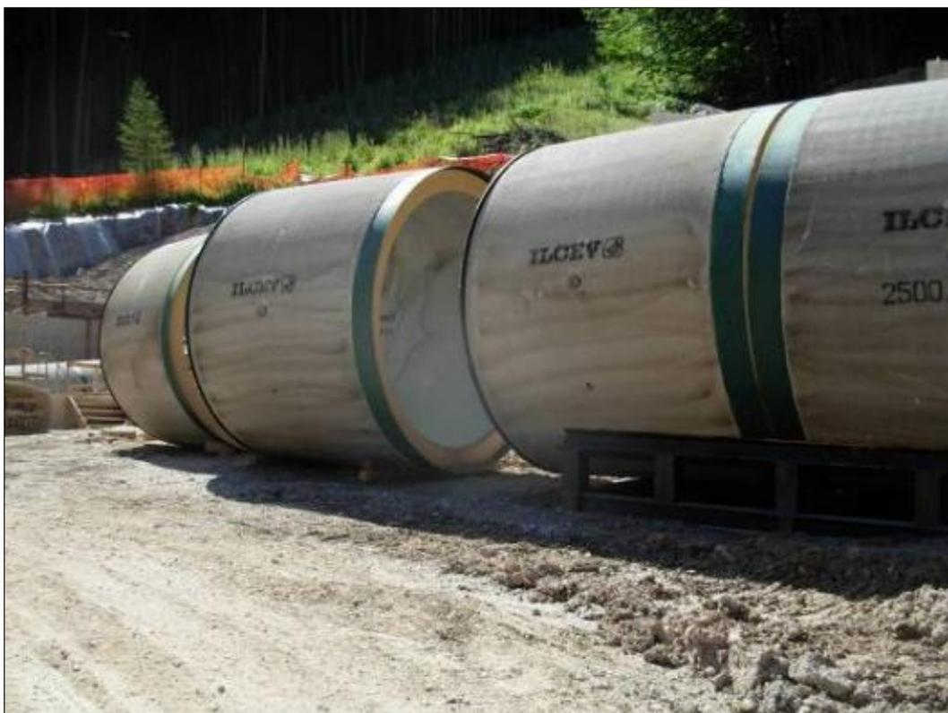
Fig. 4.22 - Stoccaggio tubi in c.a.
