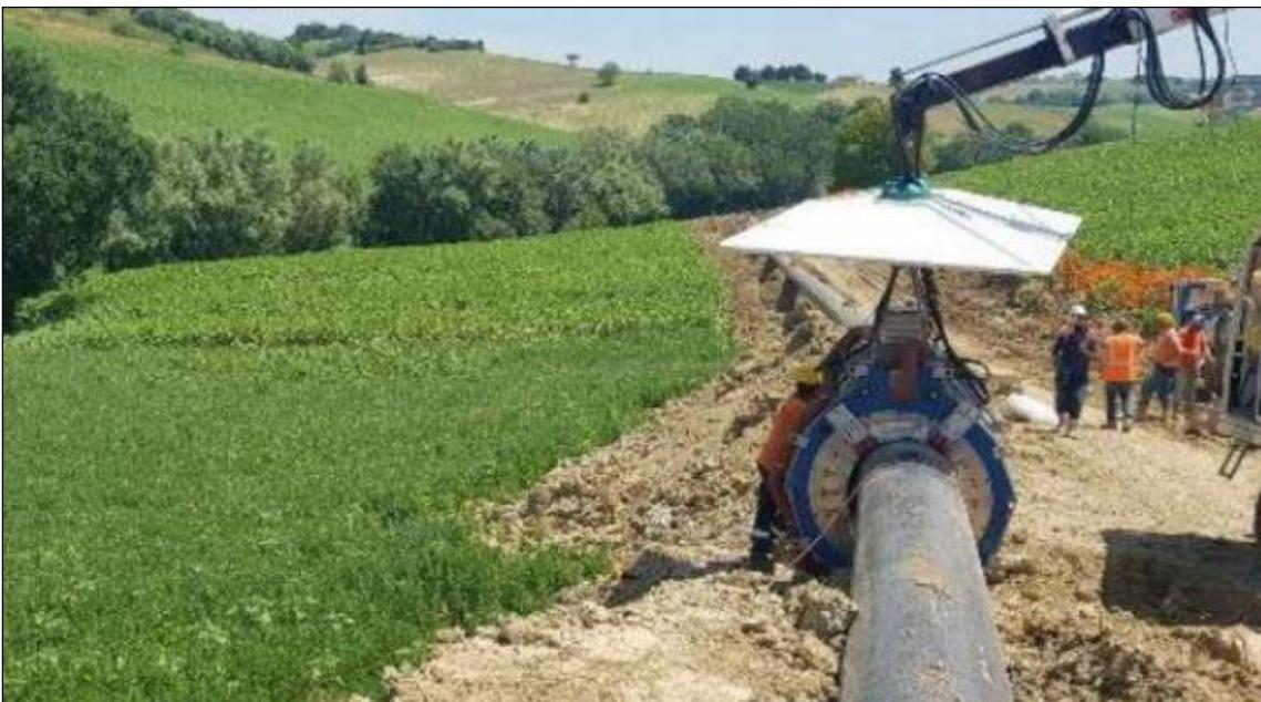
**Fig. 4.6 - Saldatura automatica.**
