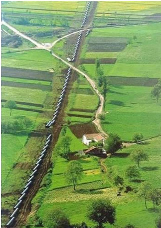
Fig. 4.4 - Sfilamento dei tubi lungo la linea.
