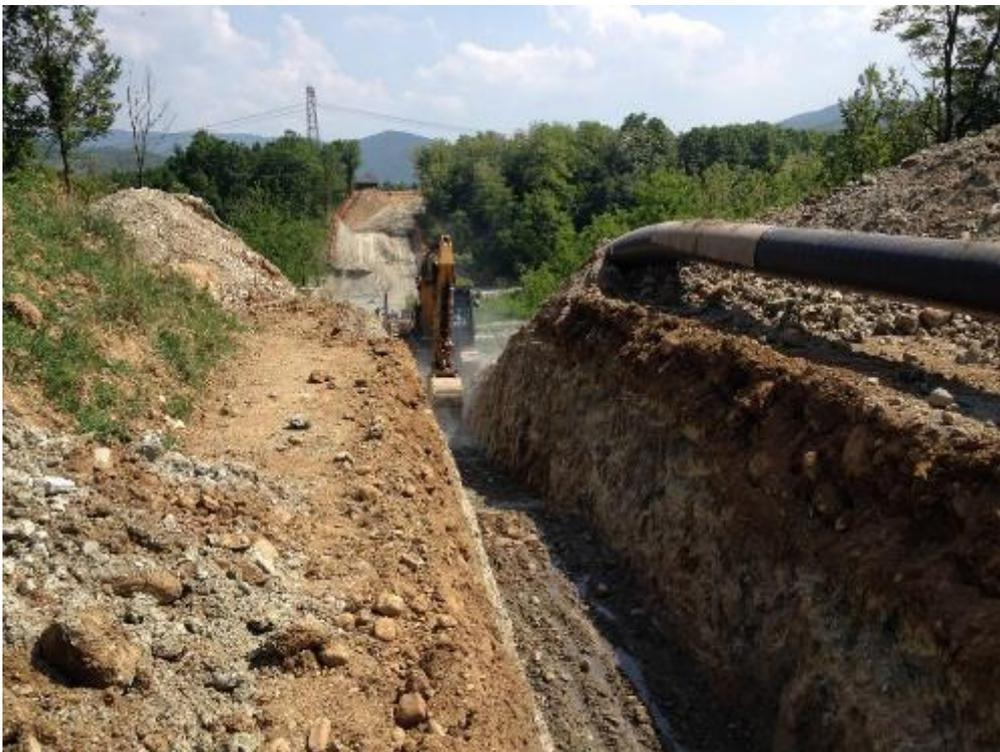
**Fig. 4.8 - Scavo per l'alloggiamento della condotta.**
