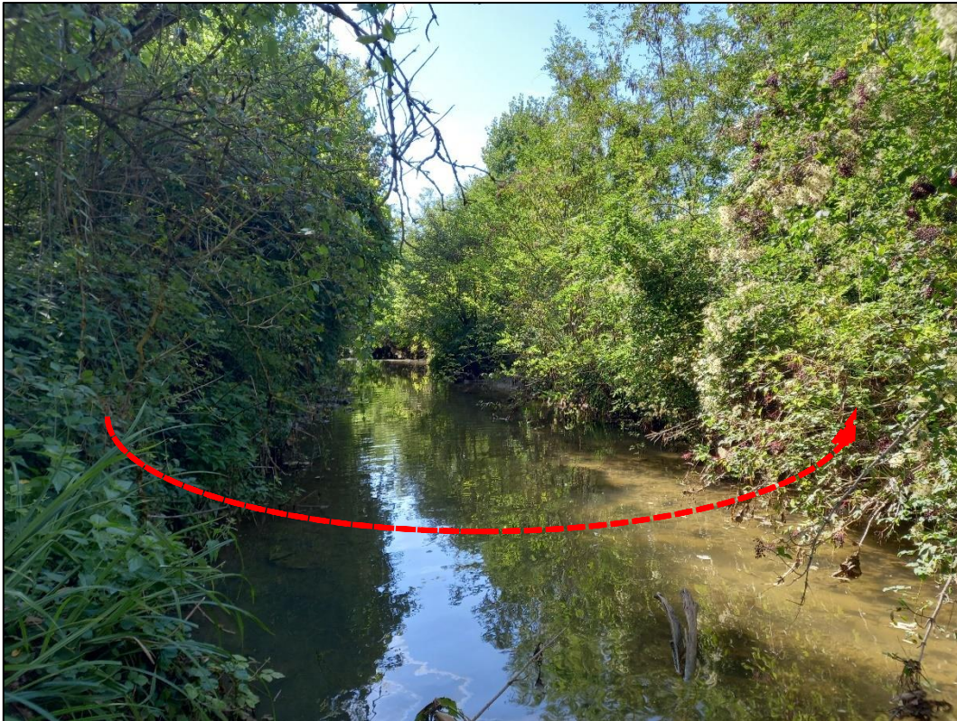
Figura 12. Bosco ripariale del Torrente Tressa nel punto di attraversamento in trenchless dell'Int.8a al KP circa 41+665. Si nota la componente significativa di latifoglie d'invasione ( Robinia pseudoacacia ).
