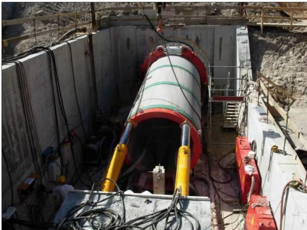
Fig. 3.8 – Postazione di spinta del microtunnel.
