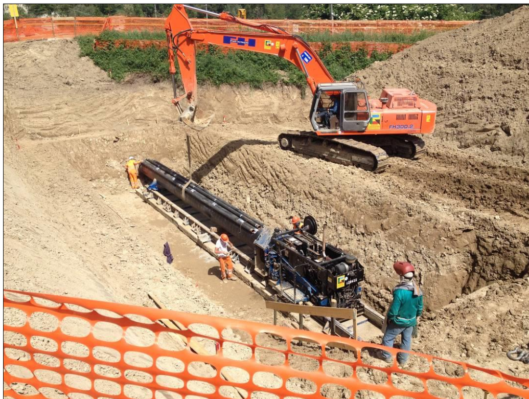
Fig. 2.2 - trivella spingitubo.
