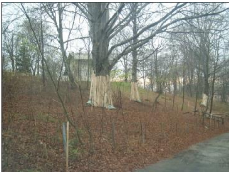
Figura 6.1 – Tecnica di salvaguardia di alberi posti all'interno dell'area di passaggio prima dell'inizio dei lavori.
