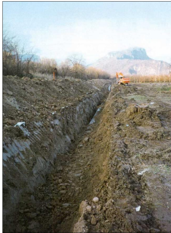
Figura 3.11 - Operazione di rinterro della condotta.
