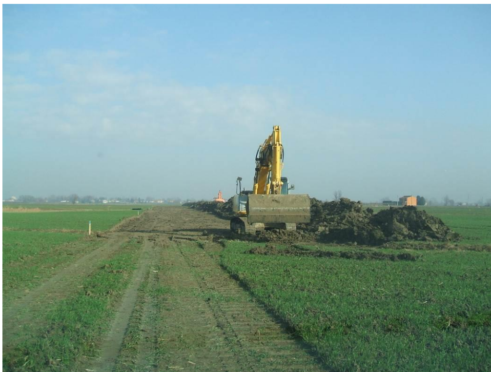
Figura 3.3 - apertura area di passaggio in area agricola
