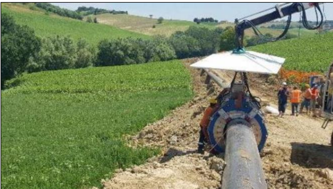
Figura 3.7 – Saldatura automatica.
