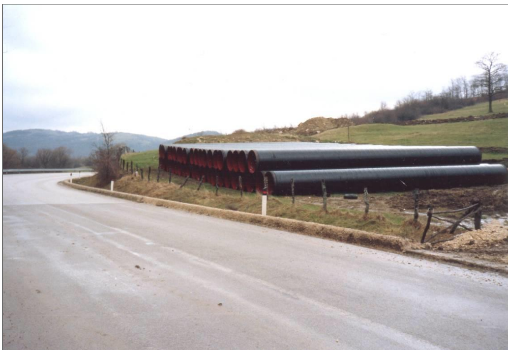
Figura 3.2 - Piazzole di accatastamento tubazioni.
