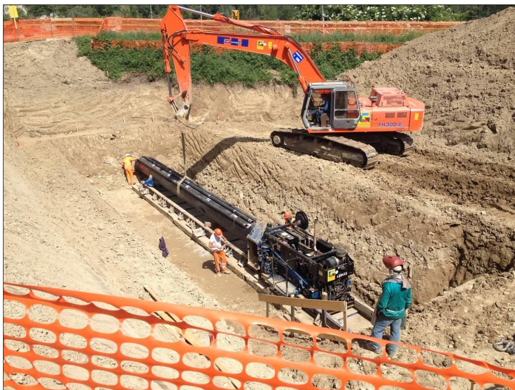
Figura 3.15 - trivella spingitubo.
