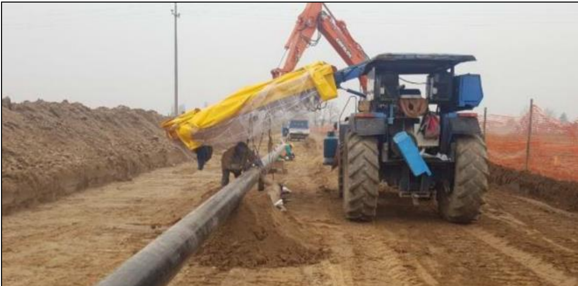
Figura 3.6 – Saldatura manuale.
