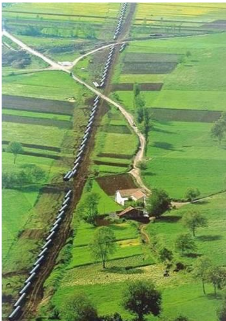
Figura 3.5 - Sfilamento dei tubi lungo la linea.
