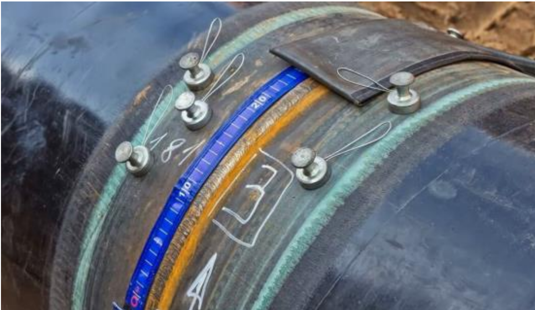
Figura 3.8 – Controlli non distruttivi sulla saldatura.
