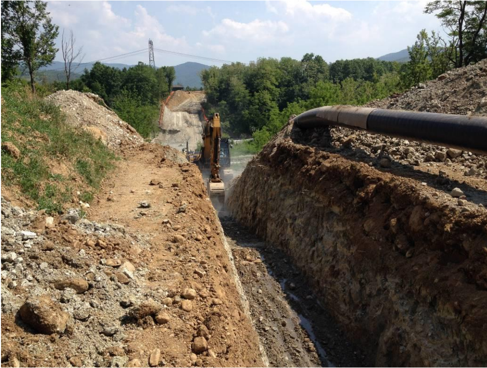
Figura 3.9 - Scavo per l'alloggiamento della condotta.
