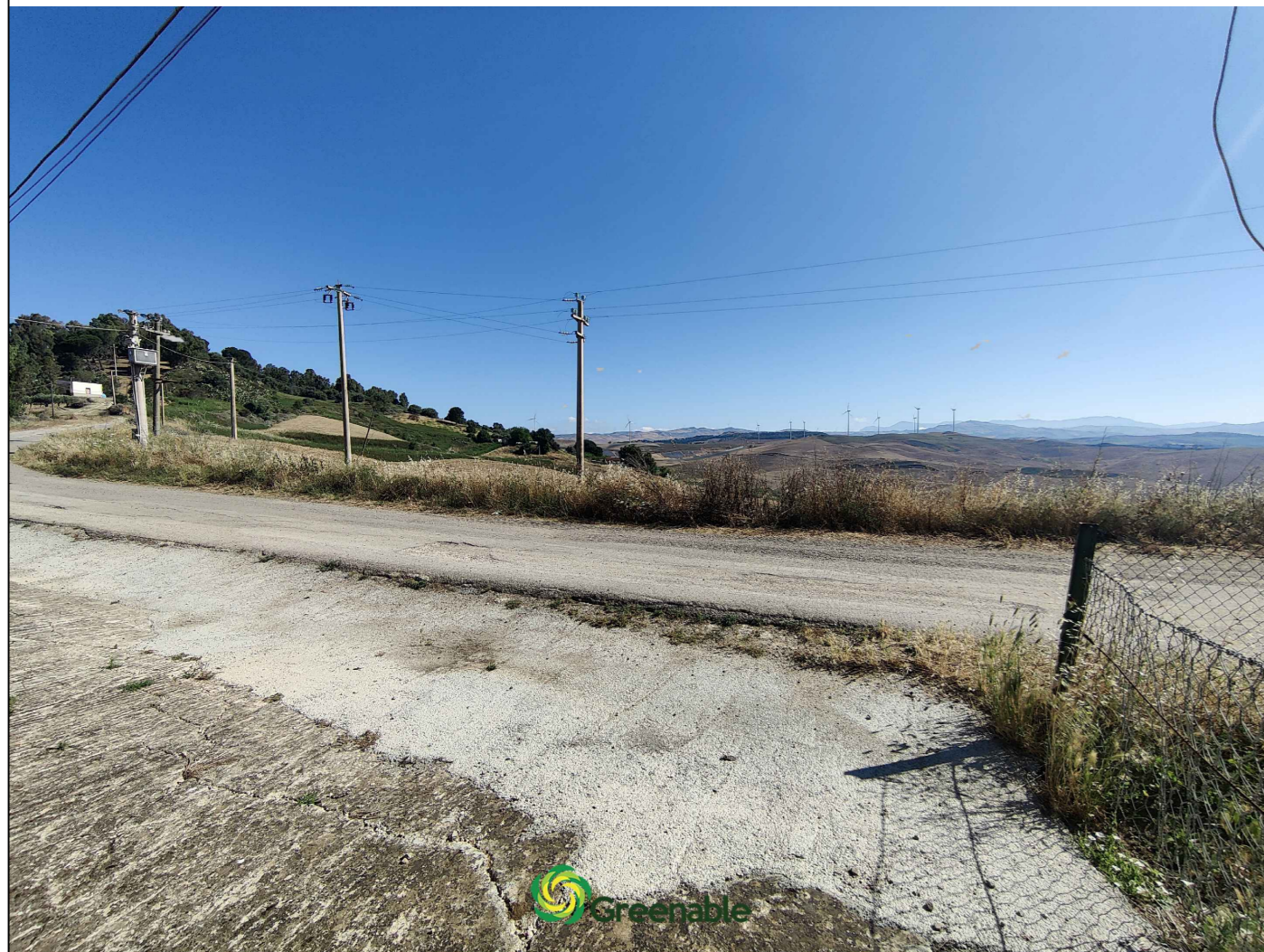
Punto 5.1: C. Baudo - Strada pubblica - POST OPERAM
