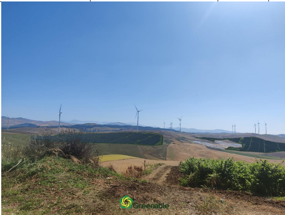
Punto 7.1: Vicino Fattoria Montoni Vecchio – Strada pubblica – SITO CON MITIGAZIONE
