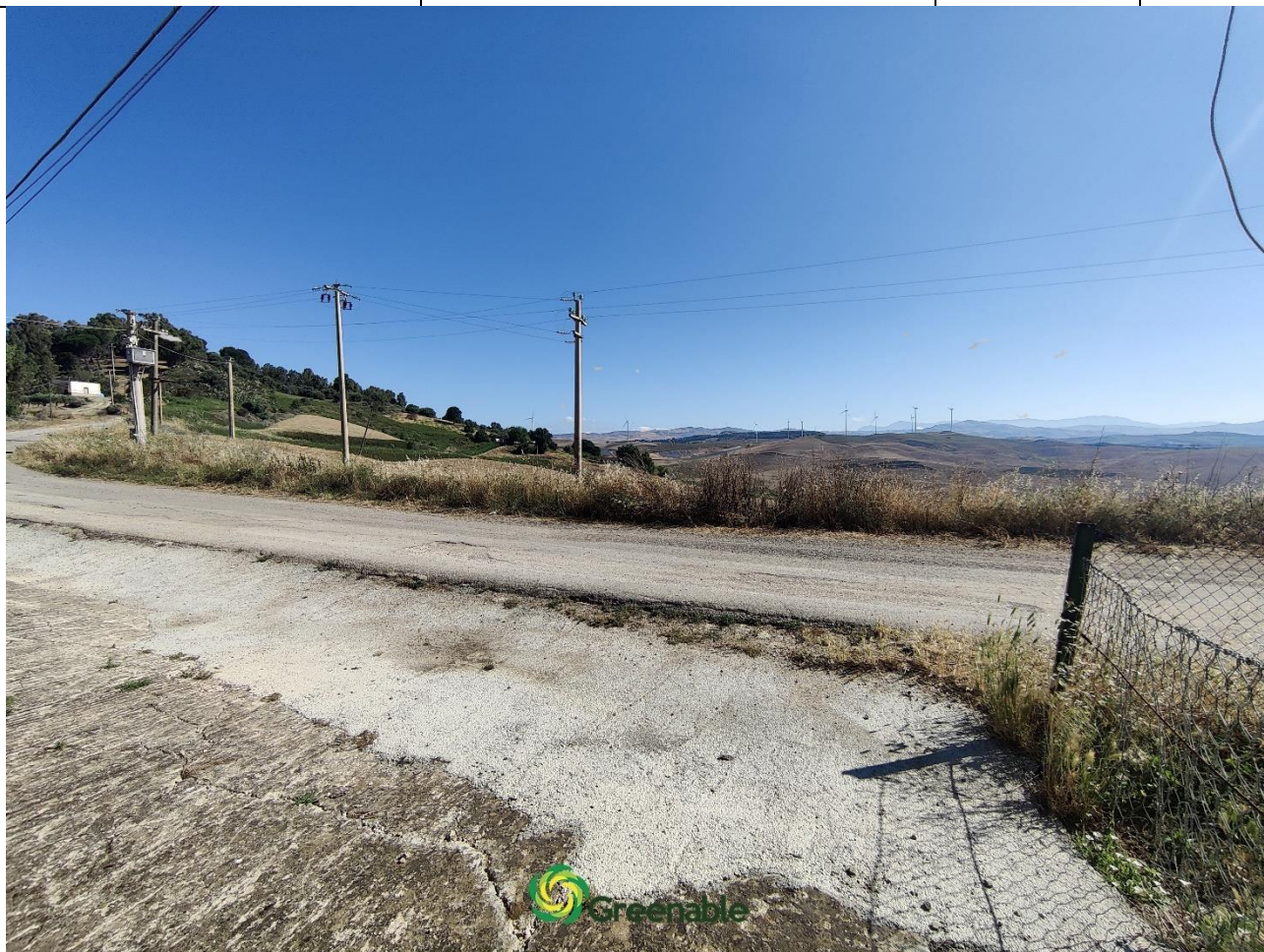
Punto 5.1 in sostituzione del Punto 4: C. Baudo – Strada pubblica – SITO CON MITIGAZIONE
