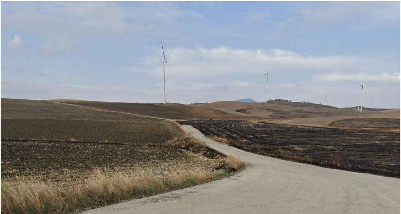
Figure 7 - Accesso al lotto da nord
