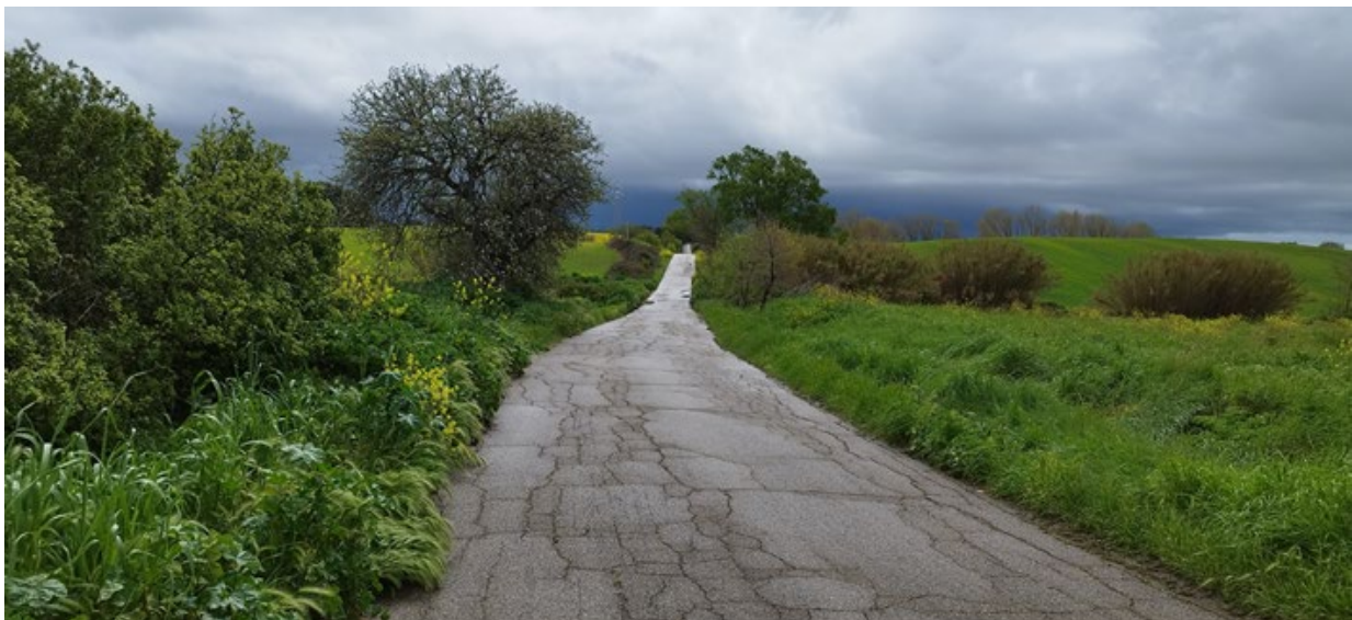
Viabilità in conglomerato bituminoso esistente in discreto stato
