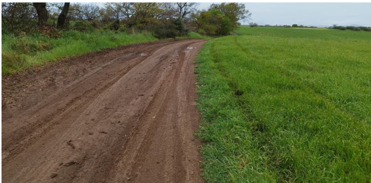
Viabilità esistente con pavimentazione naturale in buono stato
