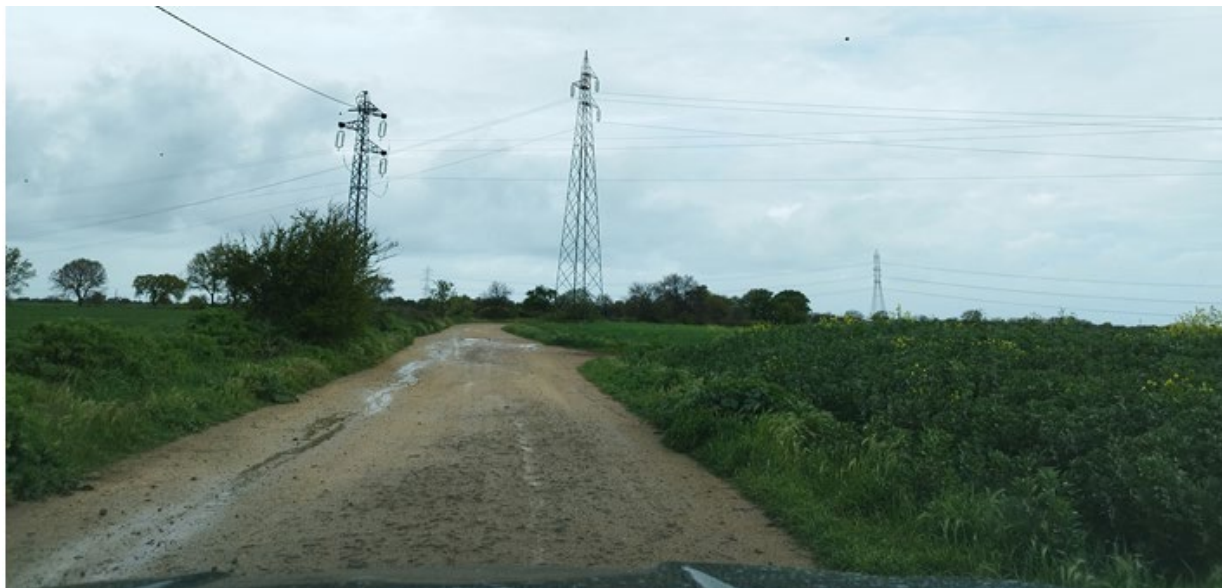
Viabilità in conglomerato bituminoso esistente in pessimo stato
