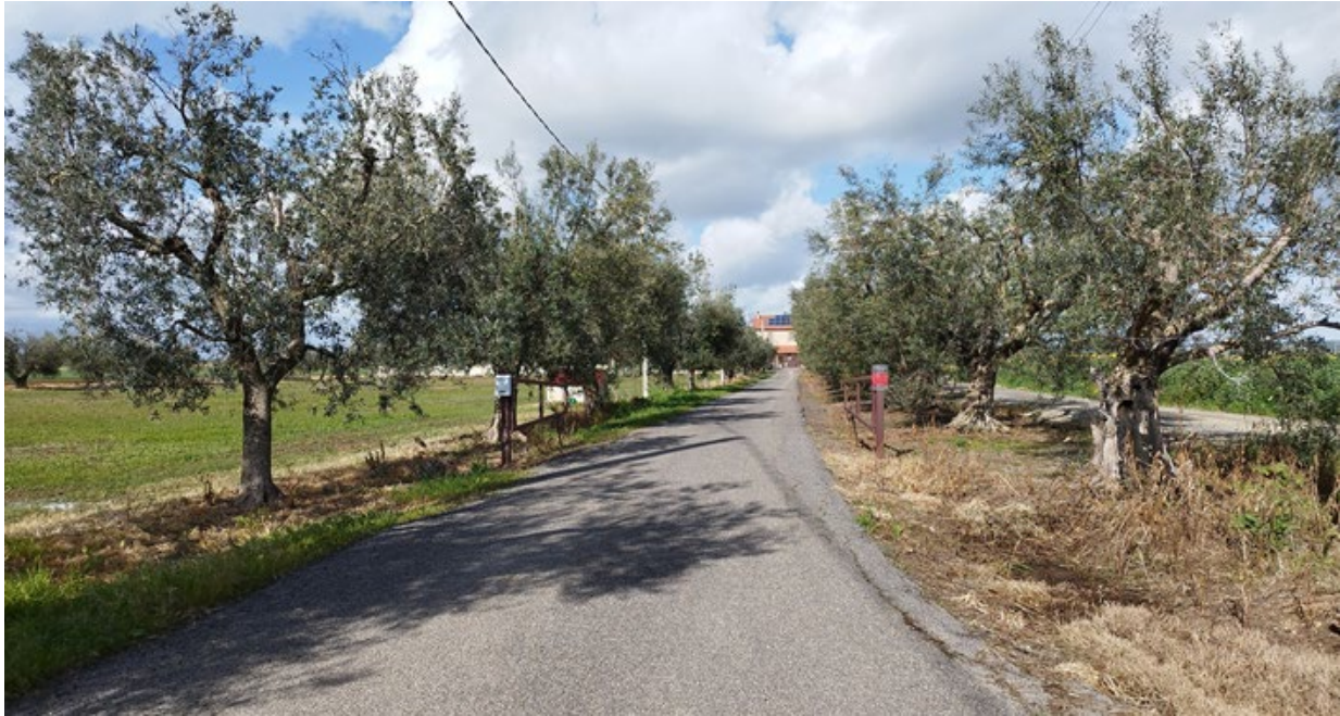
Viabilità in conglomerato bituminoso esistente
