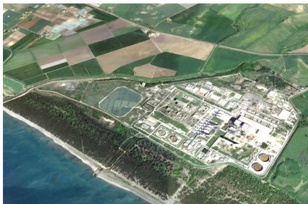
Centrale termoelettrica di Enel
