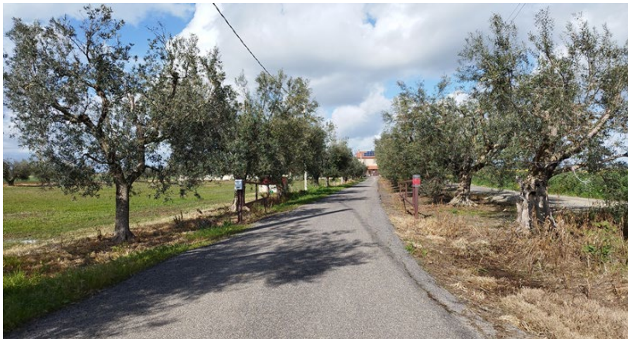
Viabilità in conglomerato bituminoso esistente
