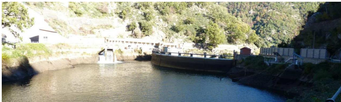
Figura 20: Diga e invaso di Orichella.
