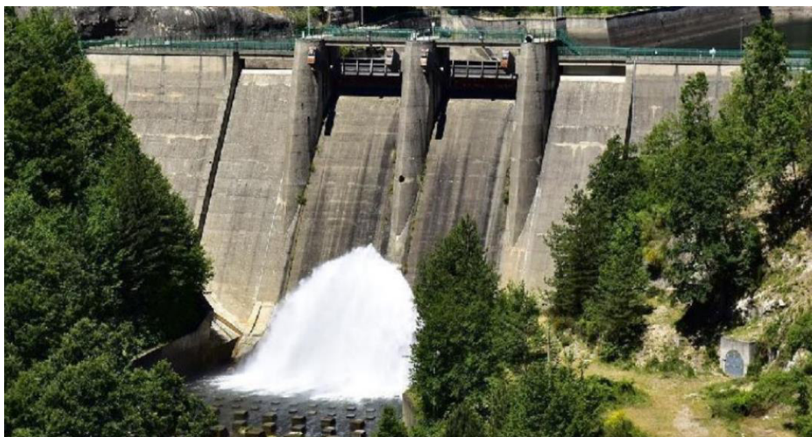
Figura 23: Diga di Migliarite.
