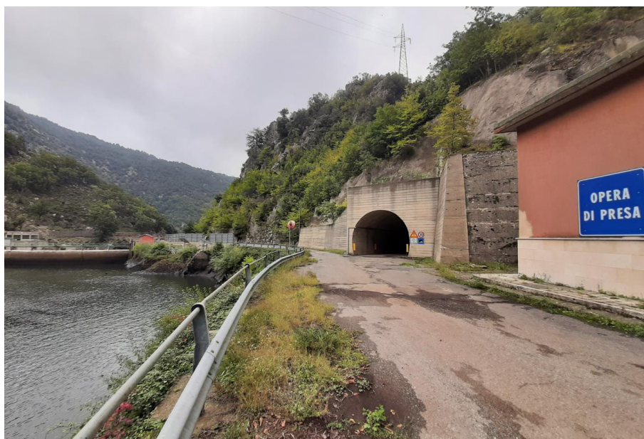
Figura 5: Invaso Orichella, sponda destra. Si osserva l'imbocco della galleria stradale e l'edificio dell'opera di presa della "nuova" galleria di derivazione (12-10-'22)
