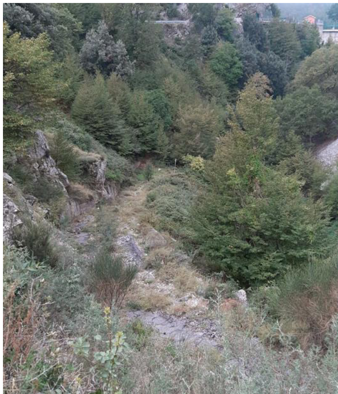
Figura 6: Sito di Orichella, sponda destra, a valle della diga. Si osserva il sedime della vecchia pista esistente, che sarà da adeguare per i lavori (12-10-'22)
