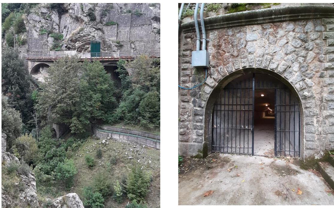
Figura 7: Galleria di accesso alla vecchia galleria di derivazione. A sinistra si osserva la strada esistente, l'imbocco dell'accesso, l'accesso pedonale al piede diga. A destra l'imbocco della galleria (12-10-'22)
