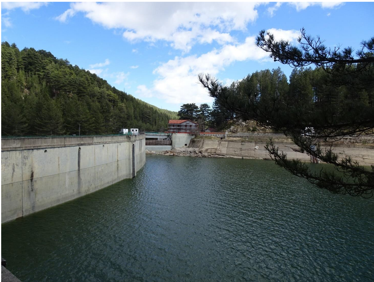
Figura 9: diga di Trepidò e serbatoio di Ampollino
