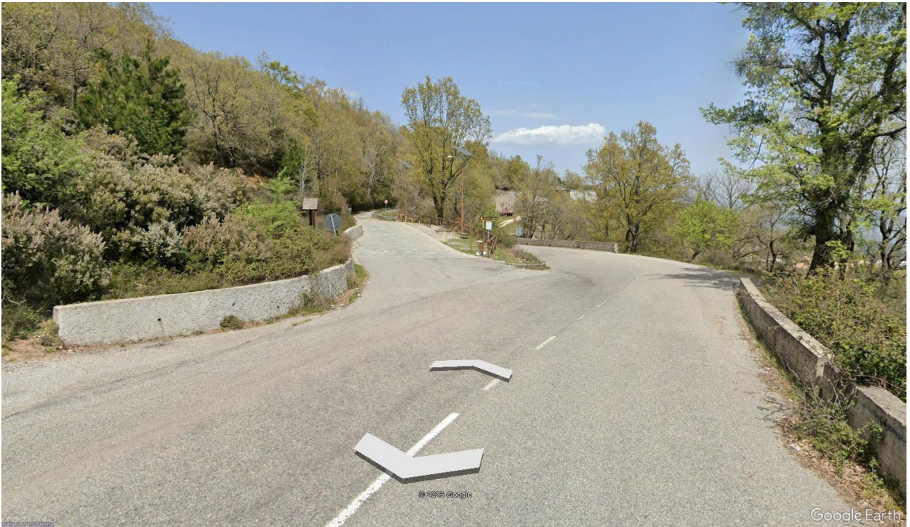
Figura 30: accesso alla strada che conduce al nodo Migliarite-Orichella e alla diga di Orichella
