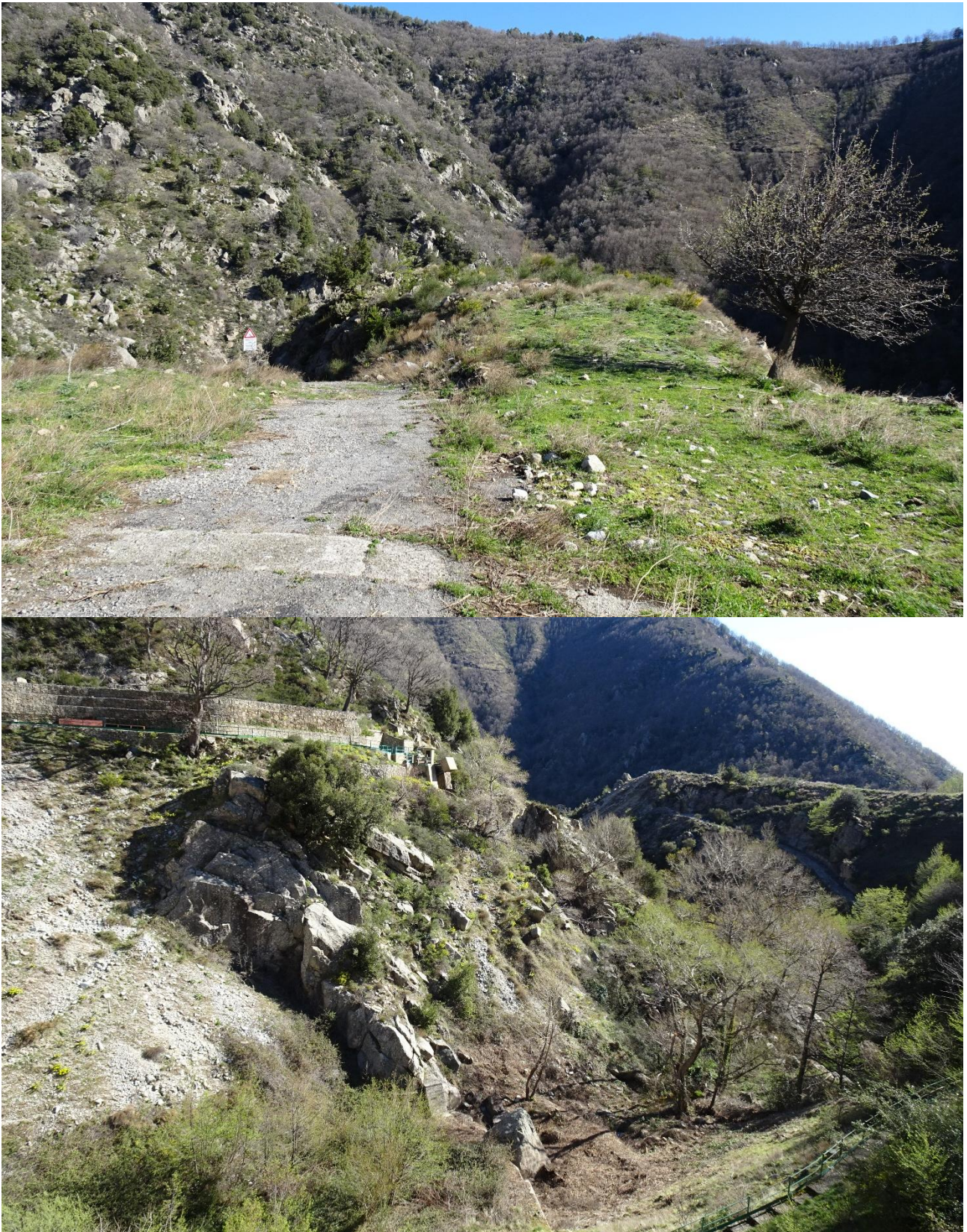
Figura 34: area di scavo del sifone e strada di accesso alle aree di lavorazione
