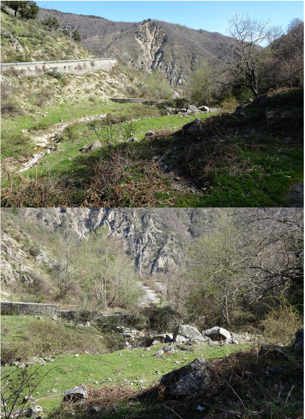
Figura 37: area di cantiere al nodo Migliarite-Orichella e strada di accesso da adeguare
