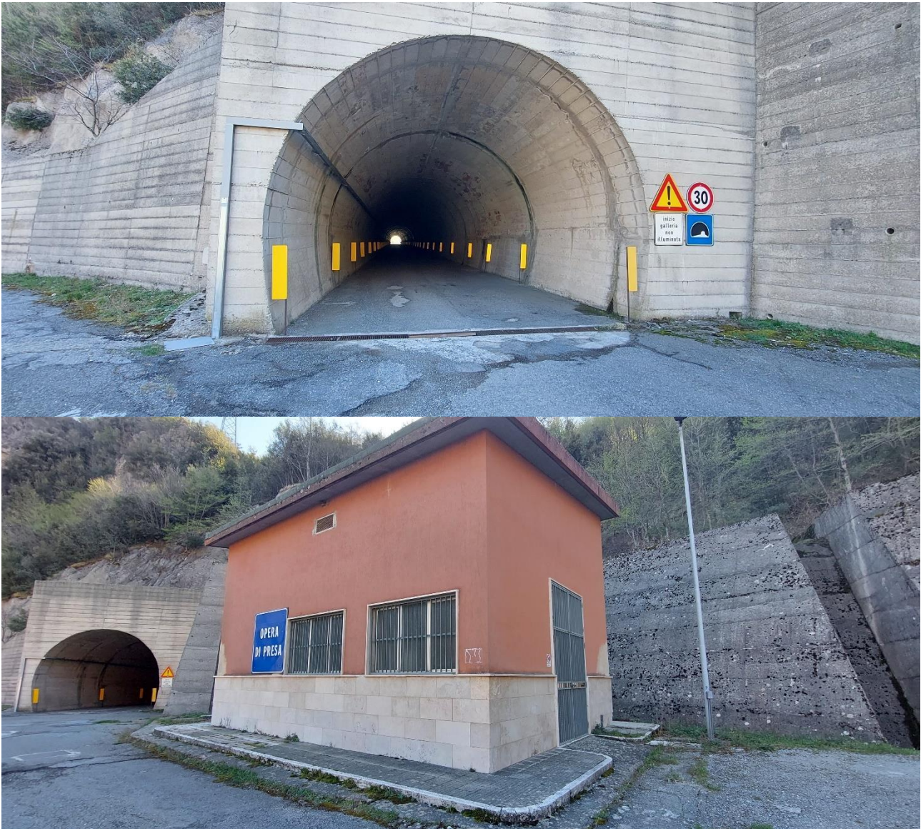
Figura 33: imbocco della galleria stradale e opera di presa della “nuova” galleria di derivazione
