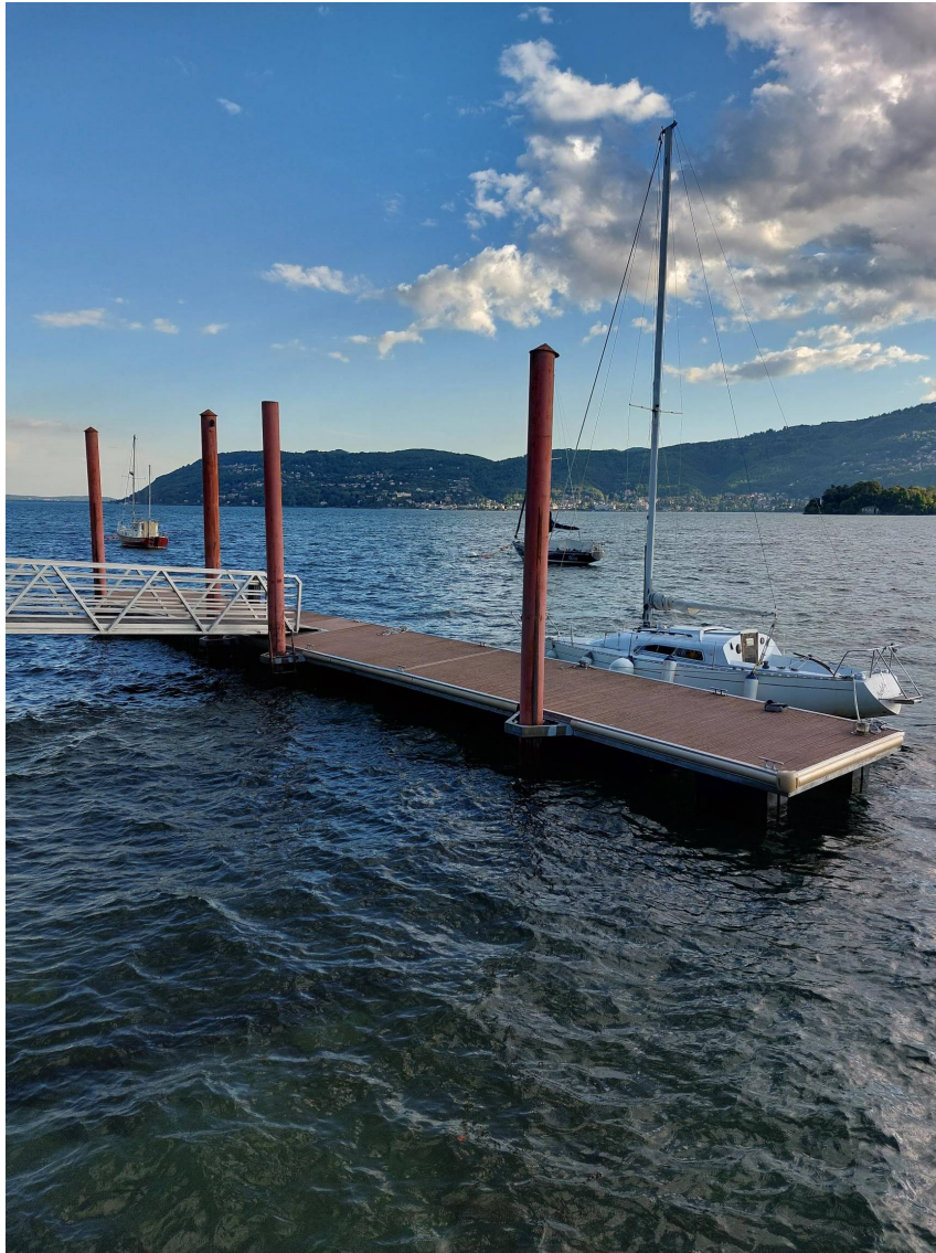
Fig. 23– Pontili di Pallanza su pali infissi
