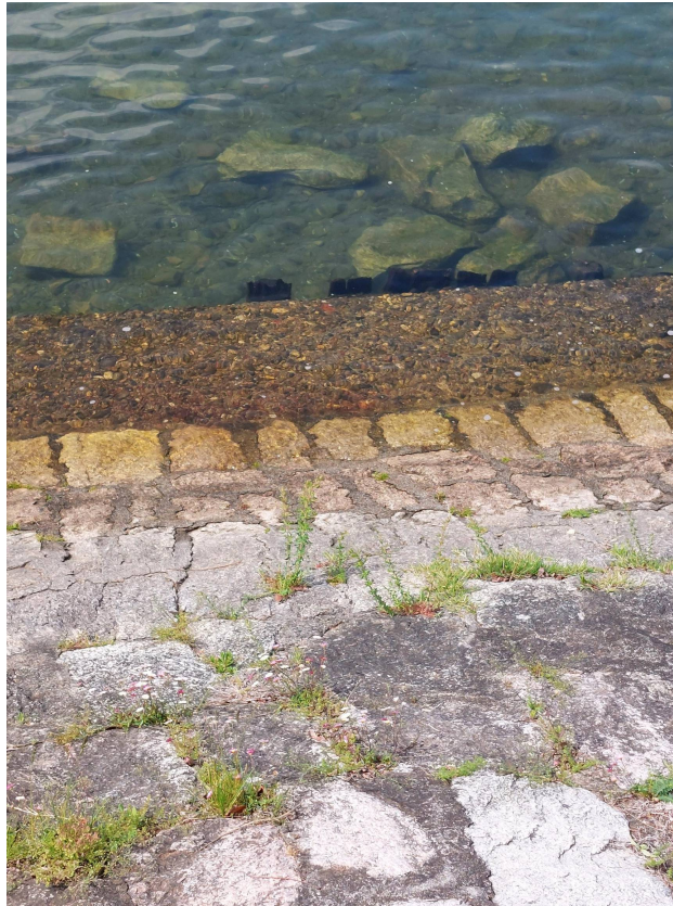
Fig. 28 – Opere di sostegno dello scivolo sottostante alla gradinata mediante palancole in legno e materiali grossolani di riporto
