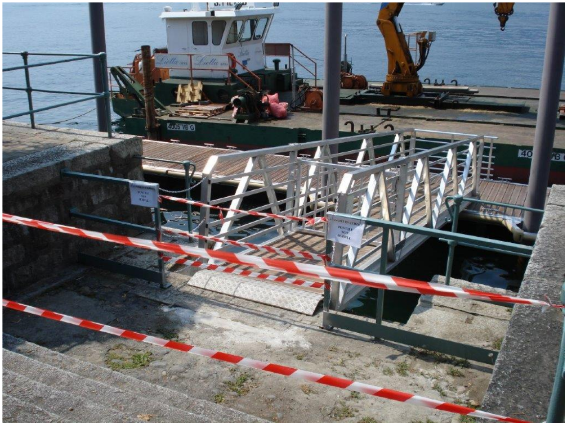
Fig. 22 – Opere di palificazione per la ristrutturazione dei pontili di Pallanza
