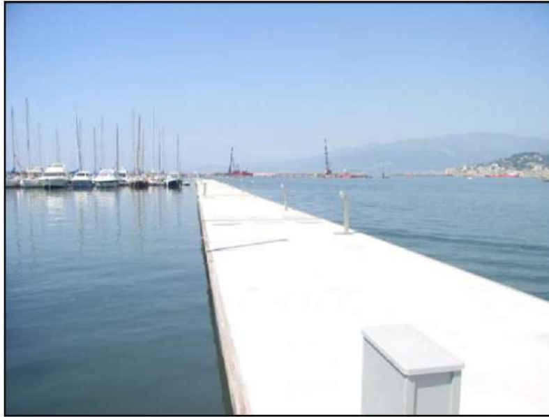
Figura 5.20 - Genova – Porto Camillo Luglio – Vista del molo galleggiante realizzato nel 2005
