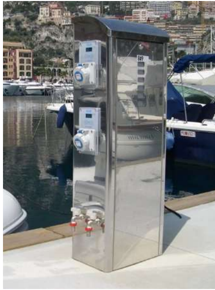
Figura 5.39 – Raffigurazione delle colonnine degli attacchi agli impianti
