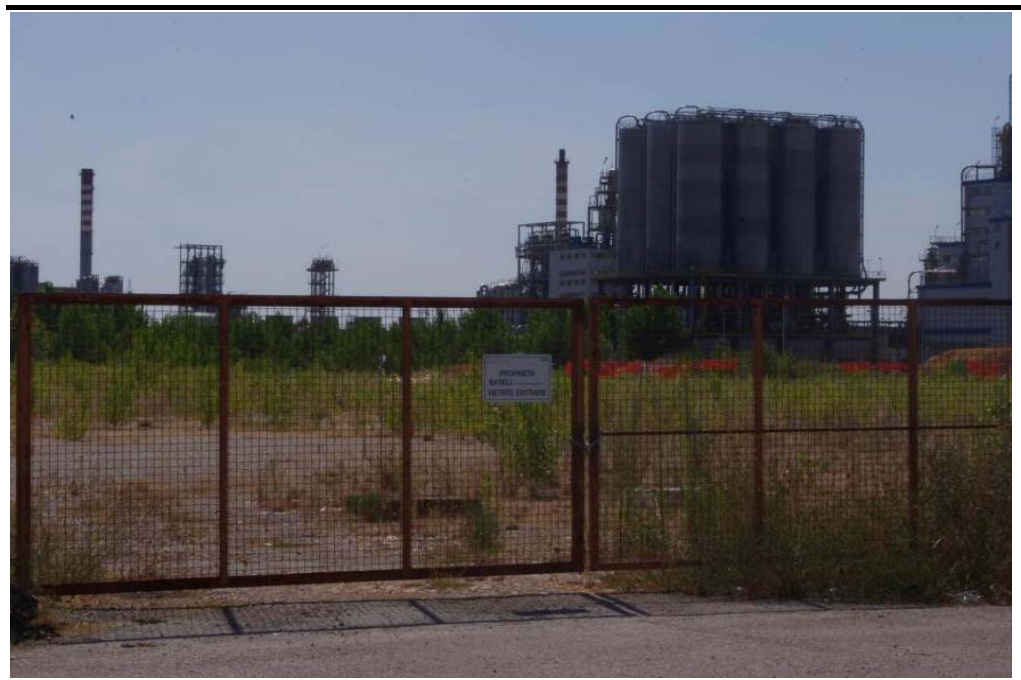
Figura 4.16 Stato Attuale del Sito di Intervento
