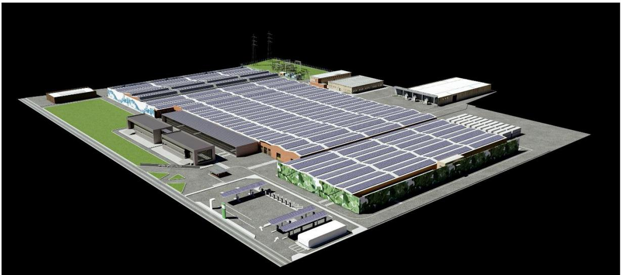
La superficie coperta dello stabilimento permette l'installazione di un **impianto fotovoltaico** di potenza pari a 7 MW<sub>p</sub>), a cui si aggiungono le aree esterne alla proprietà. Il complesso industriale si compone di varie zone destinate agli usi di seguito riportati.
