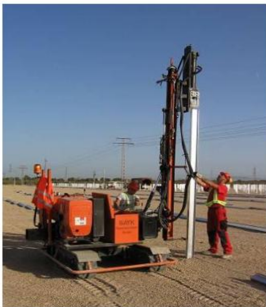
Fig.3 I pali di fondazione vengono infissi nel terreno e saranno estratti con estrema facilità e rapidità grazie all'utilizzo di mezzi appositamente progettati.
