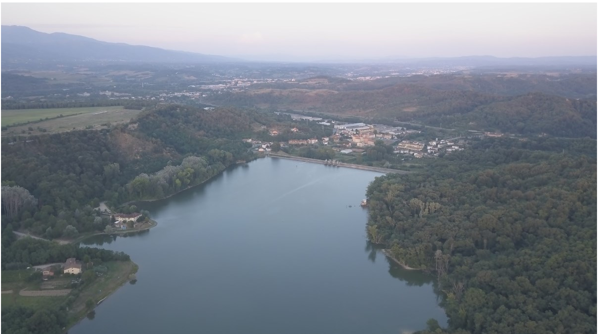
Figura 66 – Foto aerea della Diga di Santa Barbara o San Cipriano (fonte Google Earth)
