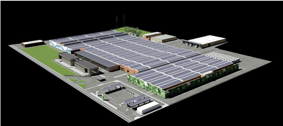
La superficie coperta dello stabilimento permette l'installazione di un impianto fotovoltaico di potenza pari a 7 MWp), a cui si aggiungono le aree esterne alla proprietà, 483.900 m2 totali, individuate per l'installazione di ulteriori 84 MWp fotovoltaici.
