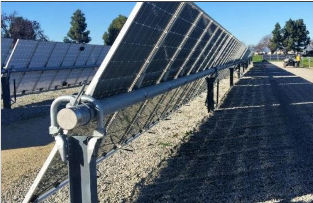
FIGURA 1 - ESEMPIO DI TRACKER FOTOVOLTAICO
