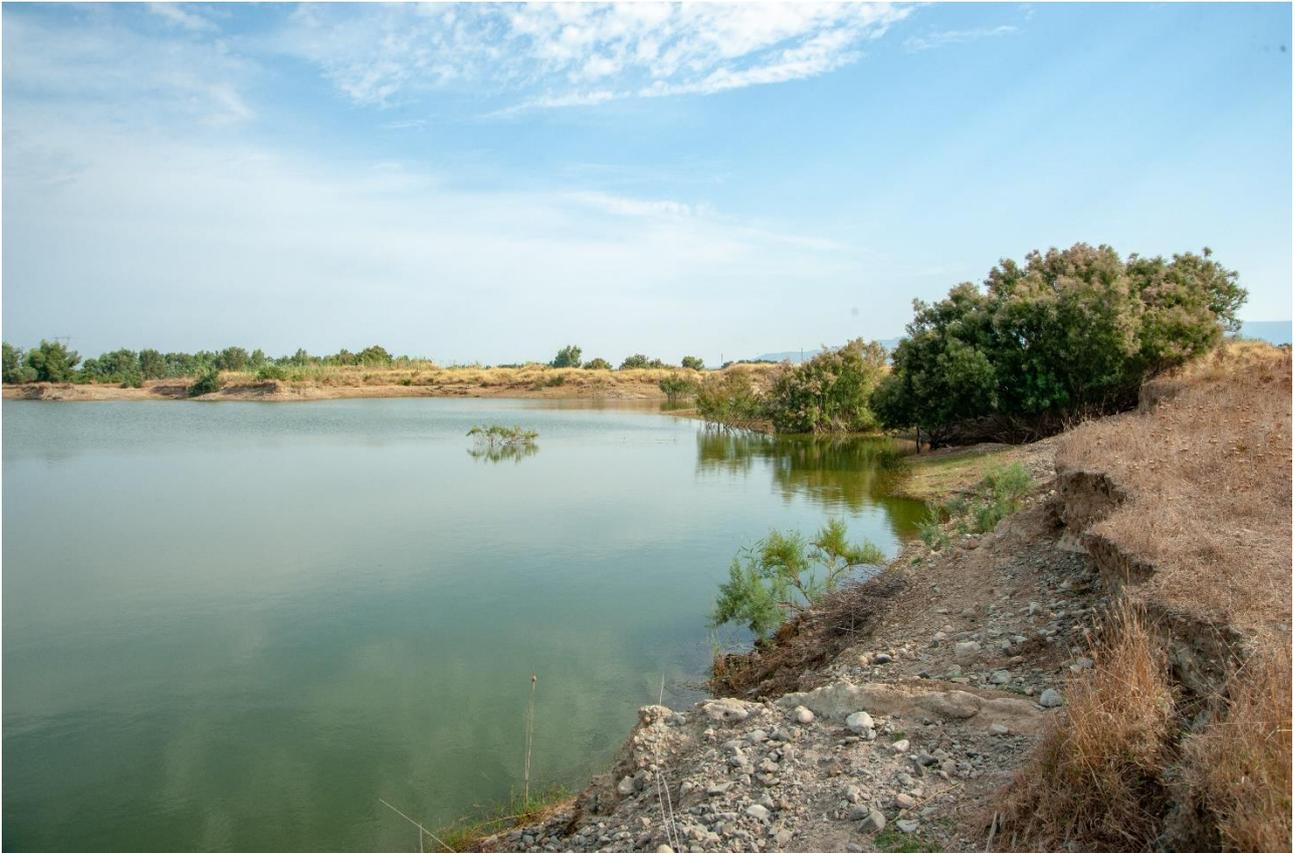
Figura 10 – tratti pericolanti in cui va attenuata la pendenza delle pareti (F017).
