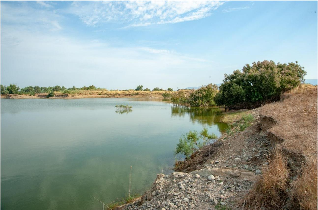
Figura 4 – tratti pericolanti in cui va attenuata la pendenza delle pareti (F017).
