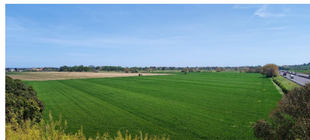
FIGURA 2-77 – VISTA STATO DI FATTO - DA STRADA PROVINCIALE HELVIA RECINA VERSO SUD
