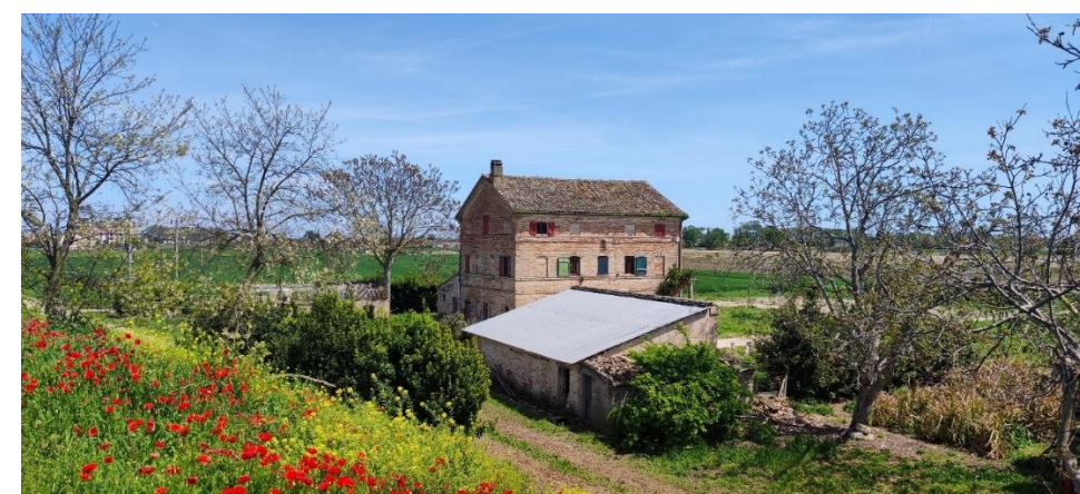
FIGURA 2-80 – VISTA FOTO STATO DI FATTO - DA STRADA PROVINCIALE HELVIA RECINA VERSO EST
