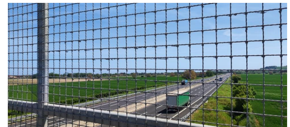
FIGURA 2-74 – VISTA STATO DI FATTO - DA CAVALCAVIA STRADA PROVINCIALE HELVIA RECINA VERSO SUD
