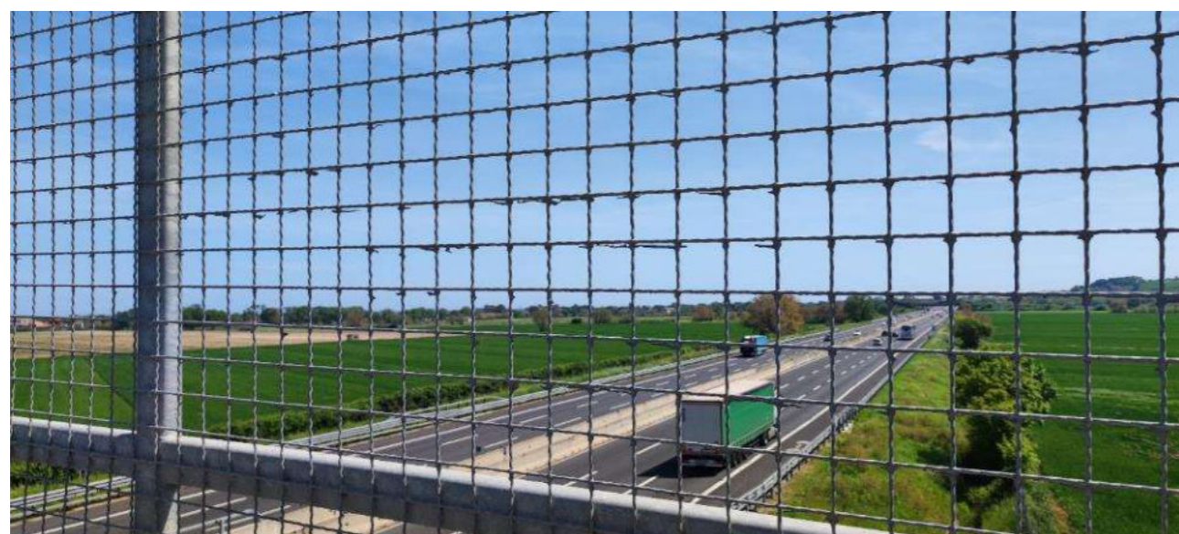
Figura 5-13 – Vista Foto stato di fatto - da cavalcavia Strada Provinciale Helvia Recina verso Sud
