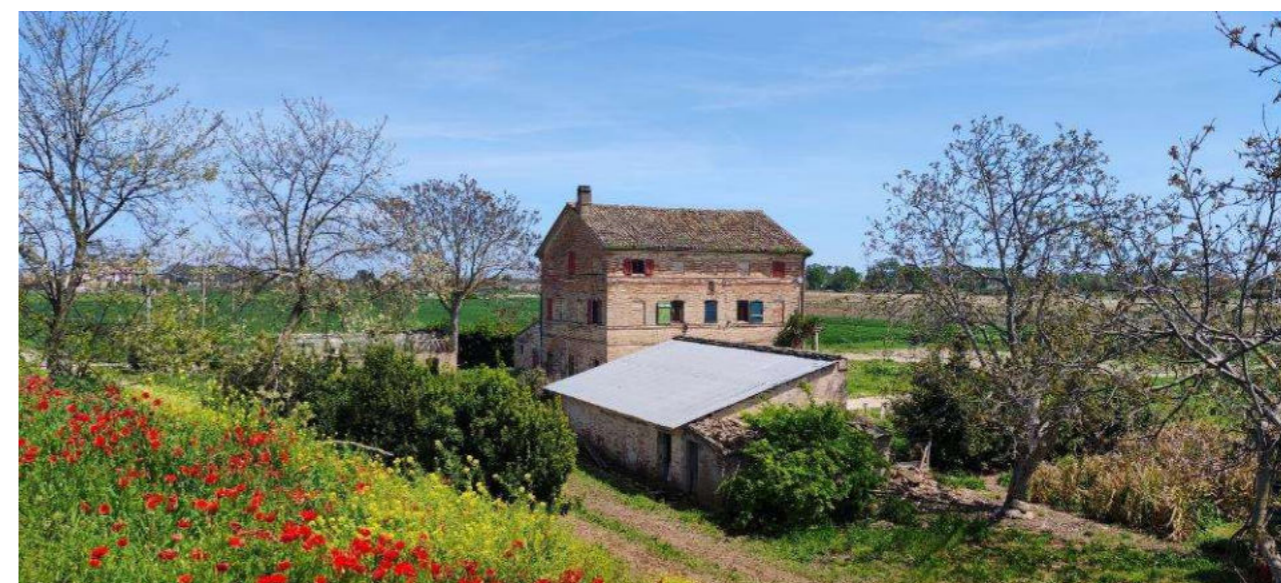
Figura 5-19 – Vista Foto stato di fatto - da Strada Provinciale Helvia Recina verso Est
