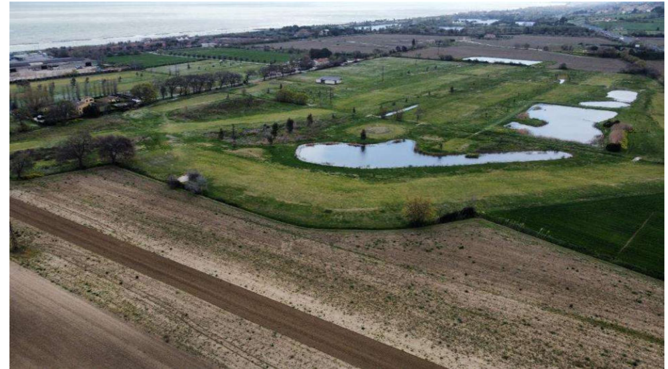
Figura 5-2 – Vista Aerea Foto stato di fatto – Direzione Sud-Est
