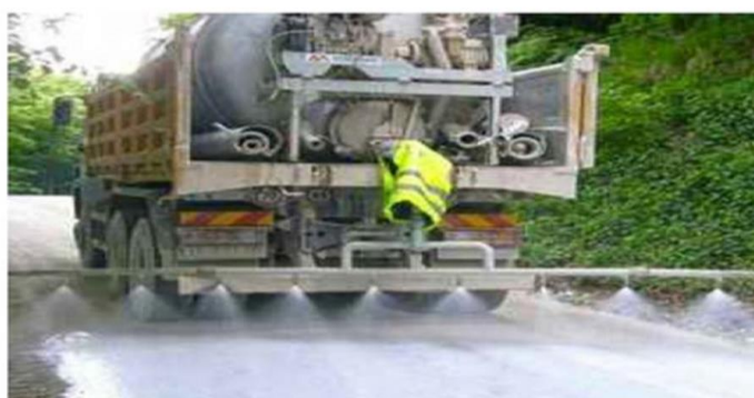
Bagnatura periodica delle superfici di cantiere
