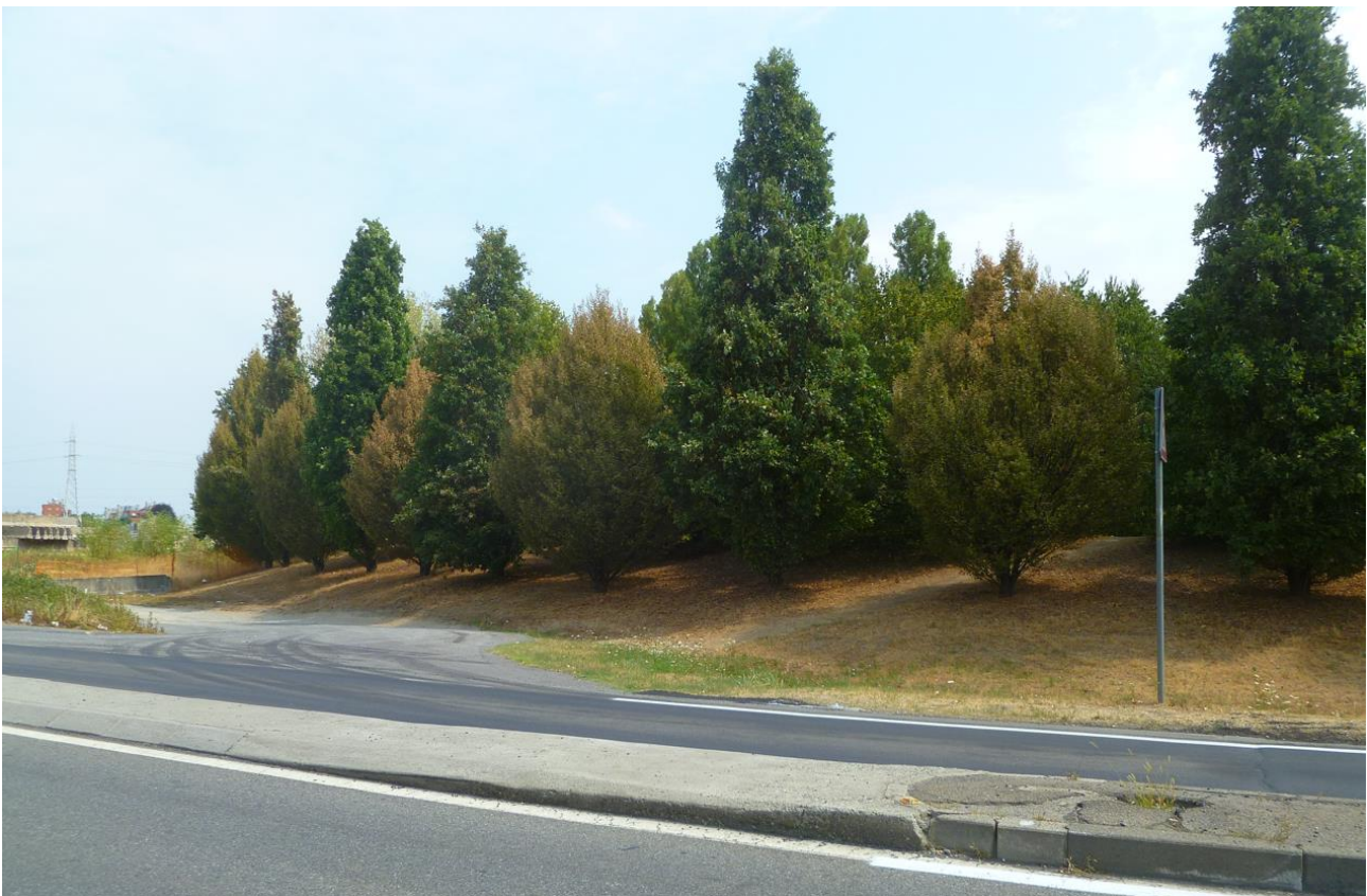
Figura 2.7 – Vista dell'ingresso dalla via G. Di Vittorio all'area di cantiere A52 in cui verrà realizzata la complanare e fascia arborata di querce e carpini piramidali su dosso estesa lungo il fronte sud (l'unità sarebbe eliminata completamente con la soluzione del Progetto Preliminare)
