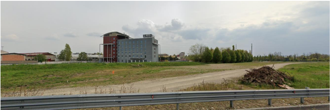
Figura 2.6 – Vista dell'area di intervento dalla rampa di ingresso all'A52 dalla rotonda esistente su via G. Di Vittorio
