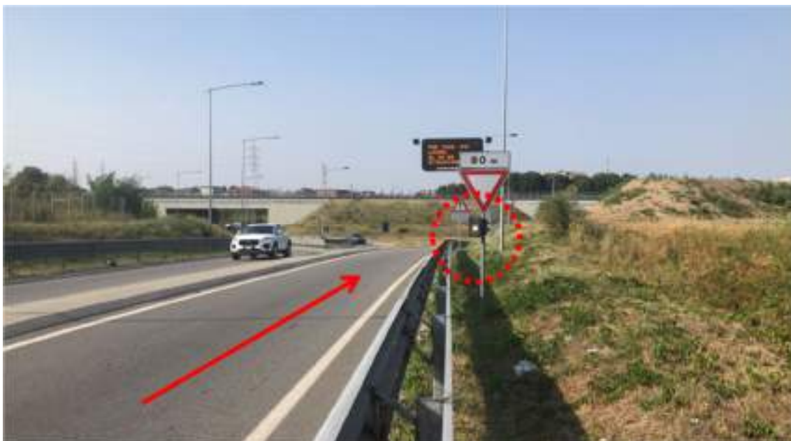
Figura 16 – Postazione Radar direzione nord
