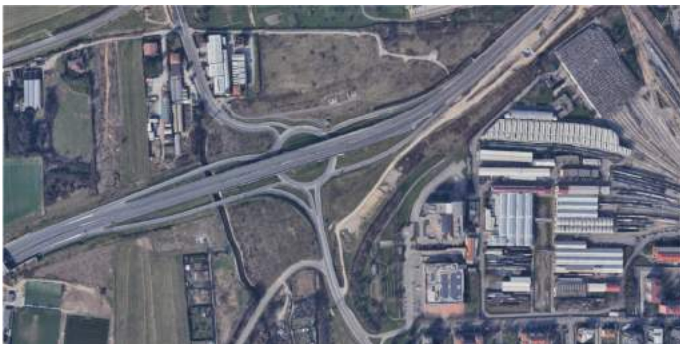
Figura 11 – Area di intervento – svincolo di Bollate
