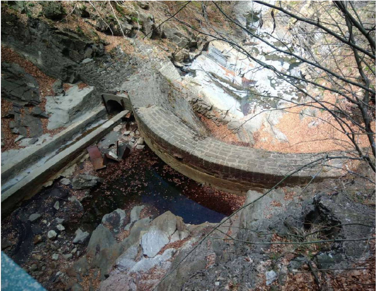
Figura 11: Area di lavoro all'interno dell'habitat 91E0*
