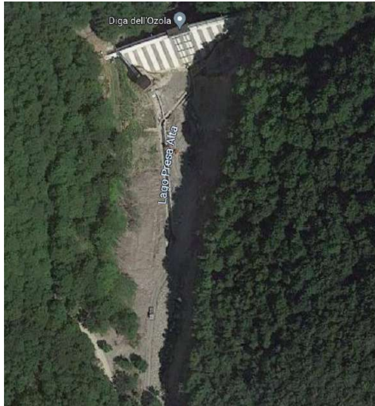
Figura 2: Estratto foto aerea Google Maps dell'area di intervento che mostra la pista di accesso all'invaso
