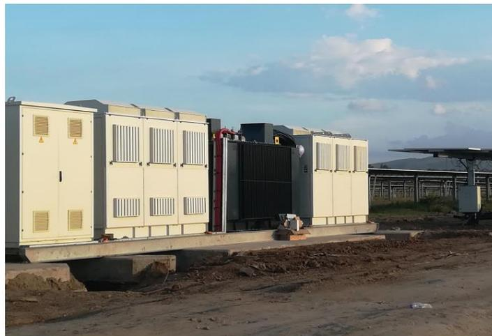
*Figura 32 - Esempio skid conversione*
