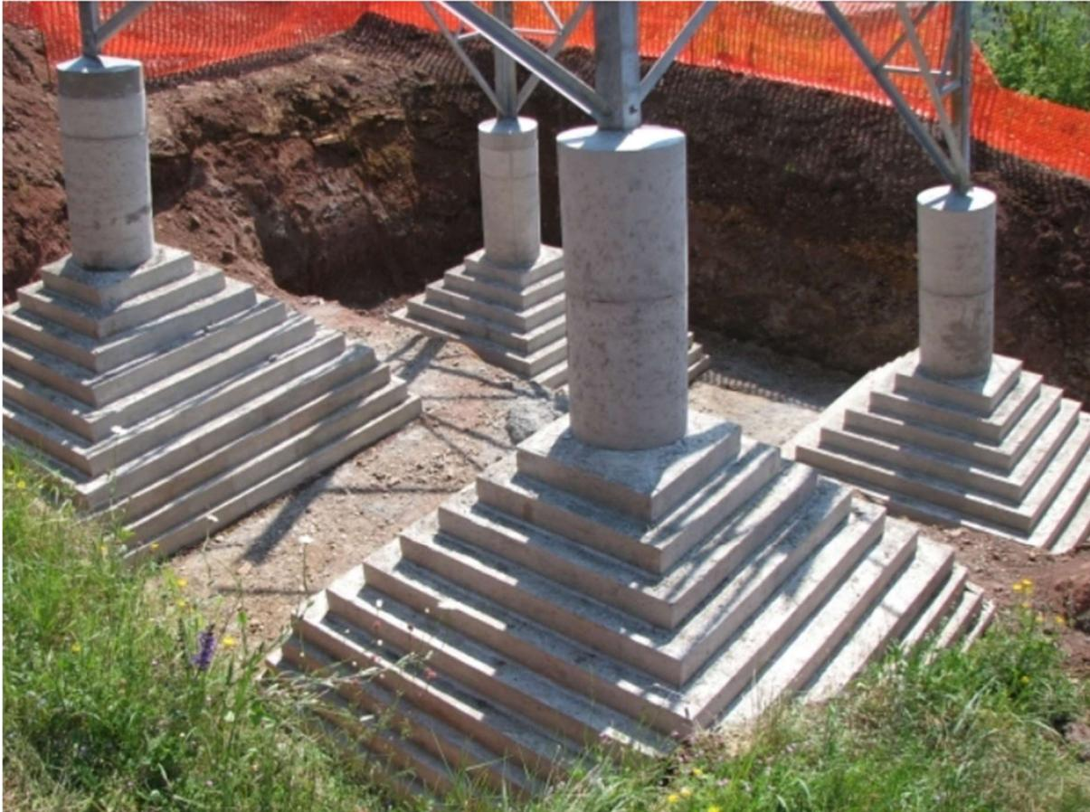
Fig. 11 – Esempio fondazione a piedino. Fonte: <https://www.marcobizzotto.it/nostri-cantieri/impianti-elettrici/linea-elettrica-schio-valdagno.html>
