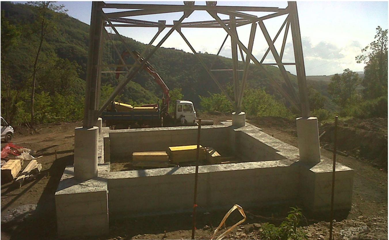
Fig. 11 – Esempio fondazione con pali trivellati con travi di collegamento. Fonte: [https://www.roda.it/impiantistica-e-grandi-opere/elettrodotti-aerei/#prettyPhotof\[Fondazioni'\]/1/](https://www.roda.it/impiantistica-e-grandi-opere/elettrodotti-aerei/#prettyPhotof[Fondazioni']/1/)
