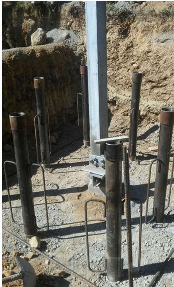
Fig. 11 – Esempio fondazione con micropali. Fonte: [https://www.roda.it/impianistica-e-grandi-opere/elettrodotti-aerei/#prettyPhoto\[Fondazioni\]/2/](https://www.roda.it/impianistica-e-grandi-opere/elettrodotti-aerei/#prettyPhoto[Fondazioni]/2/)
