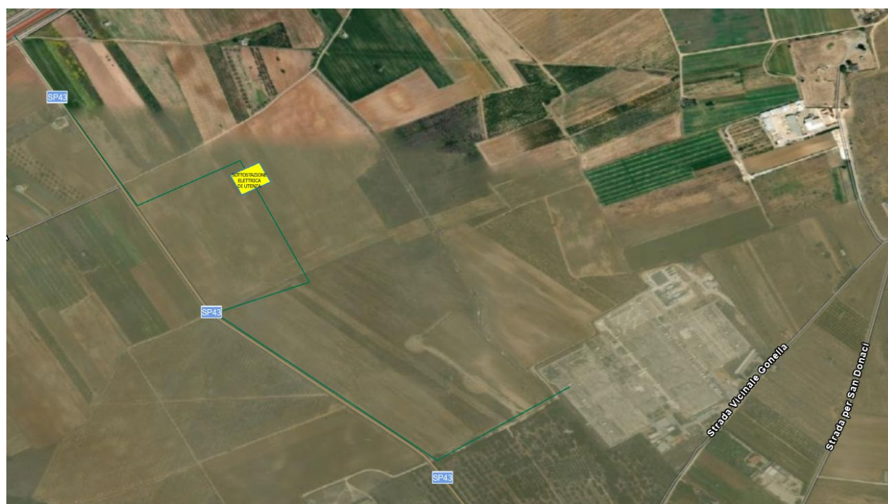
Figura 2.6 Vista della Sottostazione Elettrica di Utenza lato connessione
