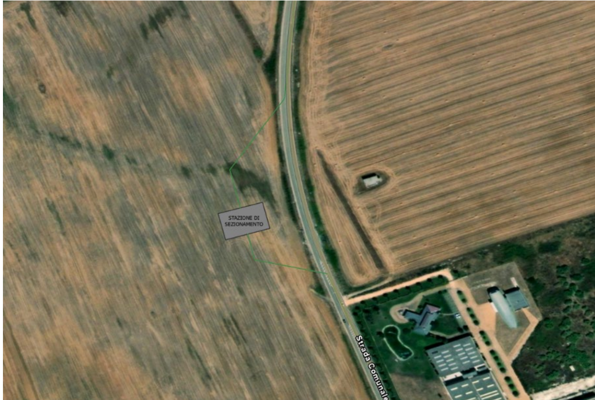
Figura 6.2 Vista della Stazione di Sezionamento
