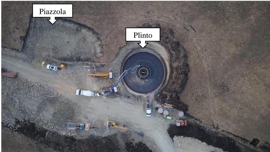
La progettazione delle piazzole da realizzare per l’installazione di ogni aerogeneratore prevede due configurazioni, la prima necessaria all’installazione dell’aerogeneratore e la seconda, a seguito di opere di dismissione parziale, per la fase di esercizio e manutenzione dell’impianto. Le piazzole nelle n. 2 fasi sono riportate nella figura 11.
