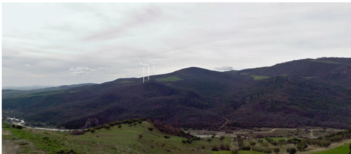
Fig.26 – fotoinserimenti da contrada Guardiola in direzione sud-ovest, verso l'impianto
