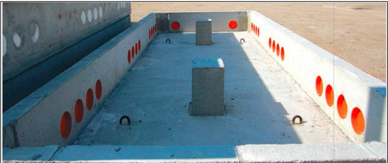
Figura 8 Vasca di fondazione in CAV
