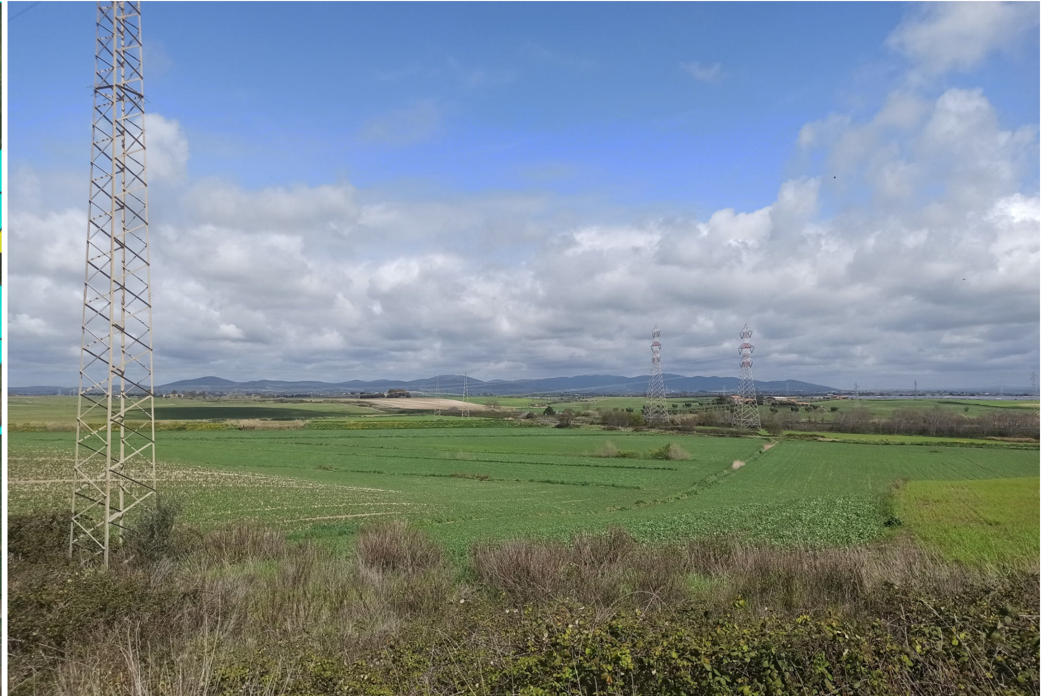
Figura 8 Stato di fatto
