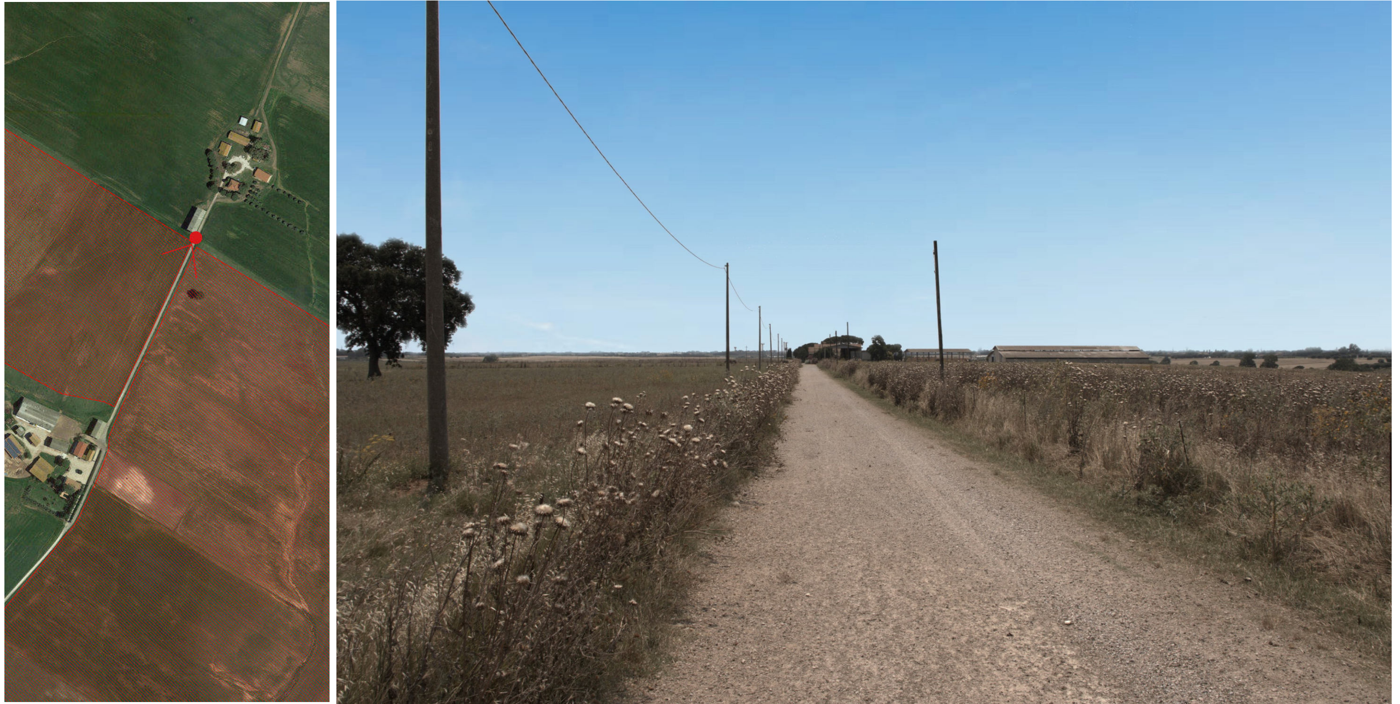
Figura 38 Stato di fatto
