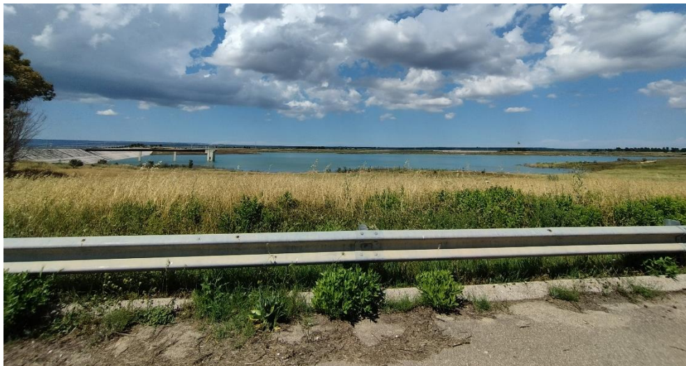
Foto 25: Inquadramento delle aree circostanti – invaso artificiale
