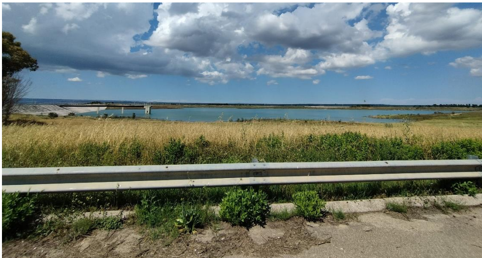
Foto 25: Inquadramento delle aree circostanti – invaso artificiale
