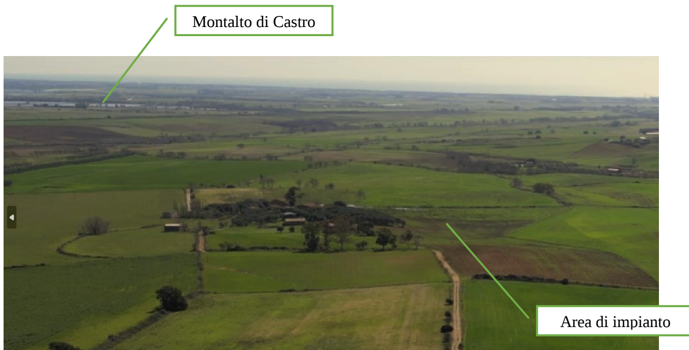
Figura 10 - Veduta dell'impianto di Montalto dall'alto
