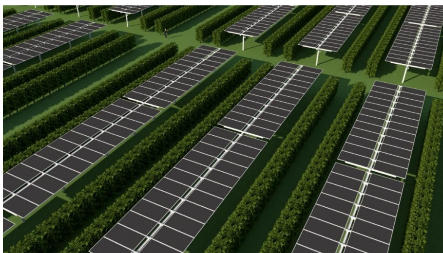
Figura 105 - Particolare del modello, siepi ulivicole e tracker in posizione orizzontale
