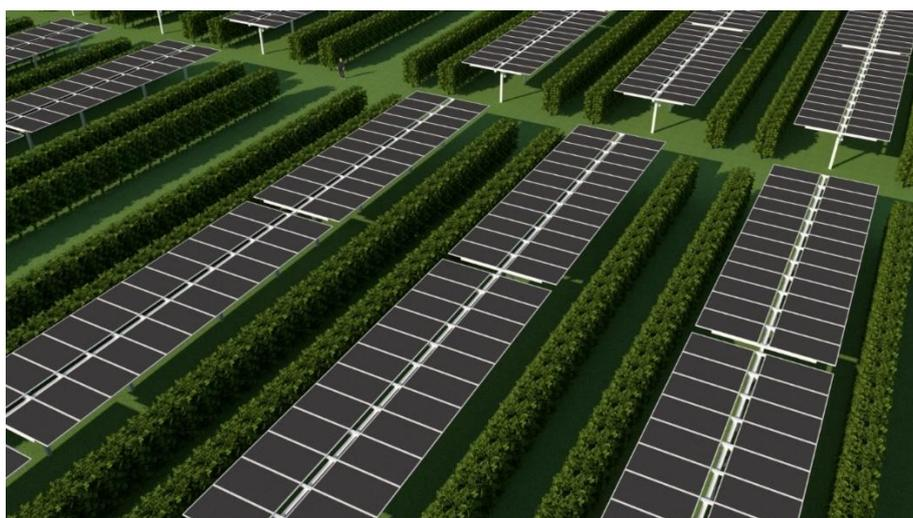
*Figura 117 - Particolare del modello, siepi ulivicole e tracker in posizione orizzontale*
